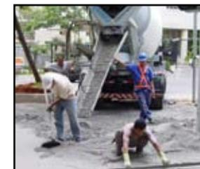
Lançamento, espalhamento e nivelamento (sarrafeamento) do concreto.
