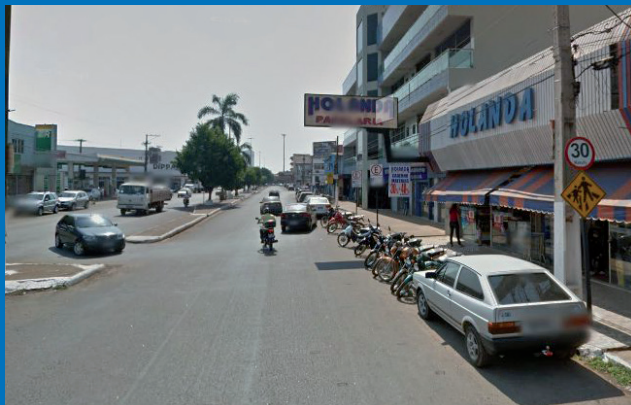
Características da via incompatíveis com o limite de velocidade estabelecido, incentivando velocidades mais altas
