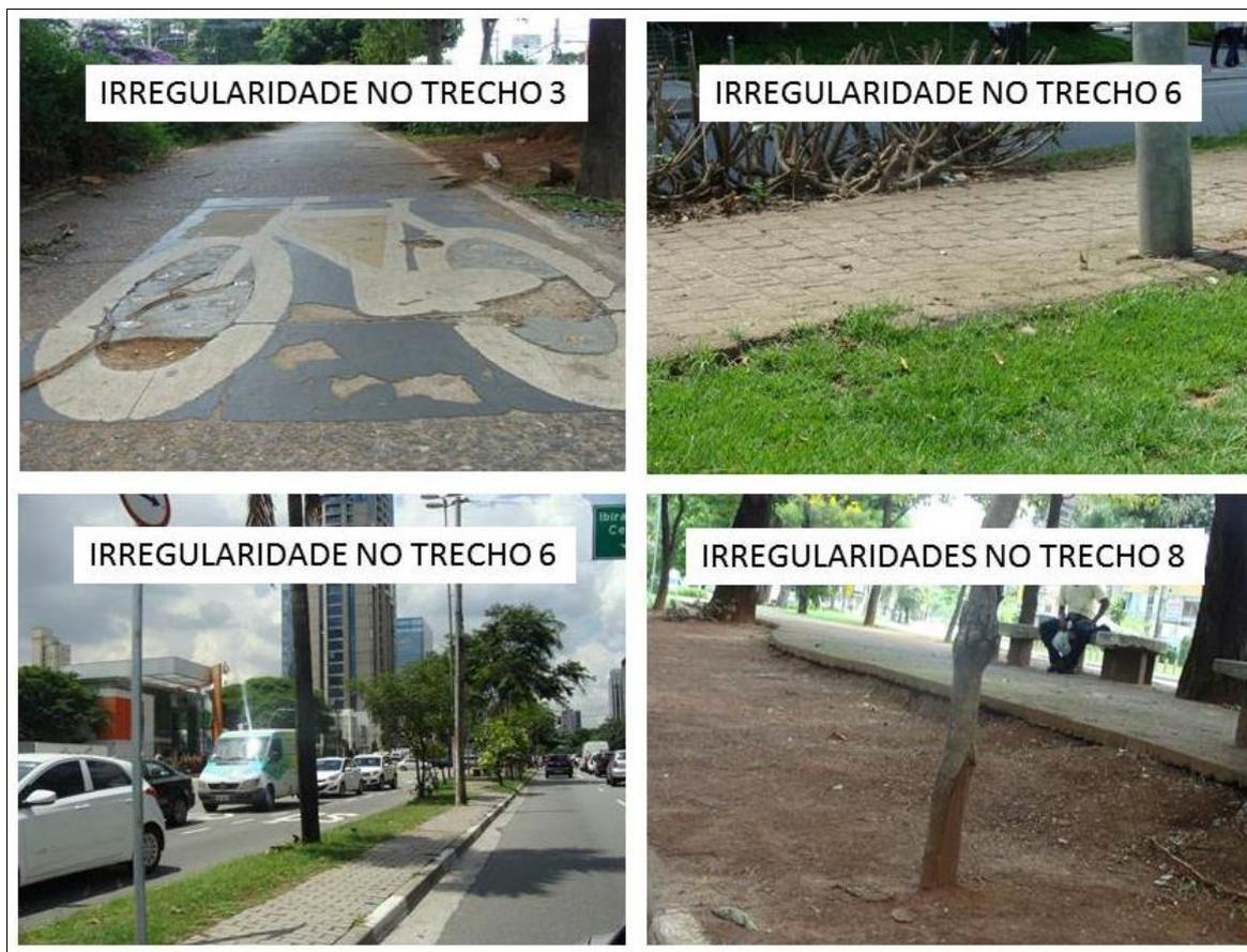
No que se refere à execução dos serviços, foram constatadas falhas de acabamento, a existência de tampa de poço de visita no meio do trajeto de ciclovia, restos de concretos e entulhos existentes no canteiro central de avenidas, além da não conclusão de serviços de concordância geométrica da ciclovia e do passeio em vários pontos.
