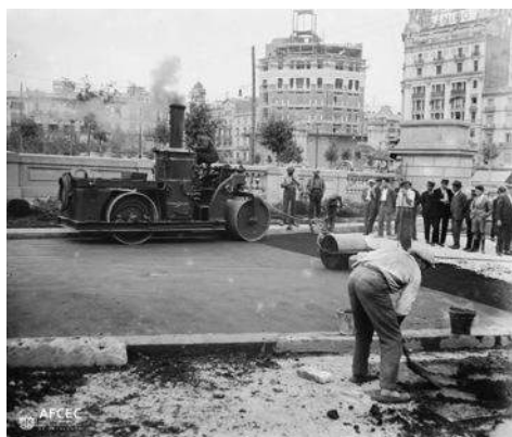
Fig. 229> Obras de asfaltado de los laterales de la plaza Catalunya (Oliveras. 1927. AFCEC)
