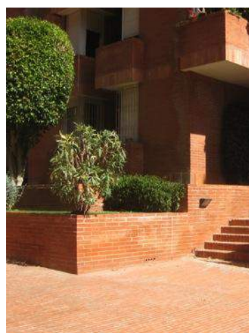
Fig. 419> Coderch (1968) conjunto de viviendas Les Cotxeres en Sarrià. El tocho es utilizado tanto para las fachadas como para la pavimentación del espacio entre edificios y la construcción de macetas, escaleras, etc.
