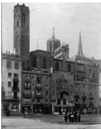
Fig. 262> Plaza Berenguer el Gran antes de la demolición de los edificios (Cuyàs. 1910. ICC)
