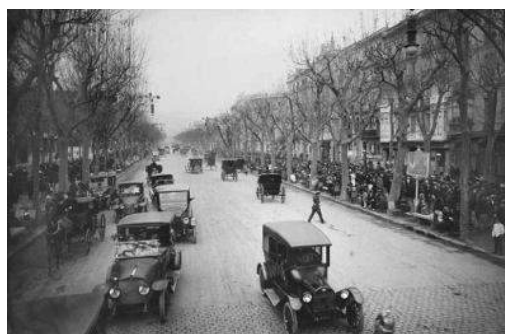
Fig. 86> Los pasos adoquinados serán construidos y reconstruidos durante la primera mitad del s.XX, en paseo de Gràcia podemos ver el paso adoquinado cuando en sus calzadas han sido ya aplicados riegos asfálticos (Brangulí. 1920-1925. ANC)
