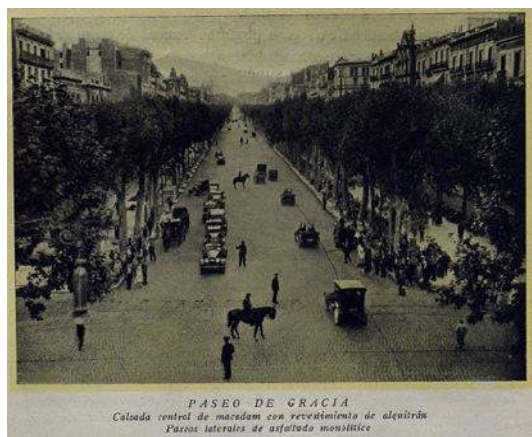
Fig. 183> Paseo de Gràcia, pavimentada con Macadam con revestimiento de alquitrán (Ajuntament de Barcelona 1926, p.26)
