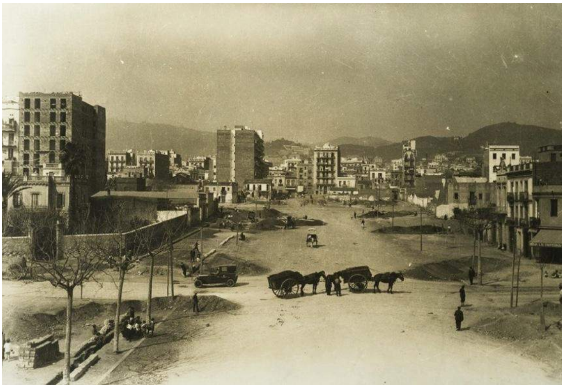
Fig. 81> Tras la apertura y explanación de las calles se procede a la colocación del bordillo y la plantación del arbolado, retrasándose de forma habitual su pavimentación definitiva tras la construcción de los edificios (Dominguez. 1930. Passeig Sant Joan. AFB)
