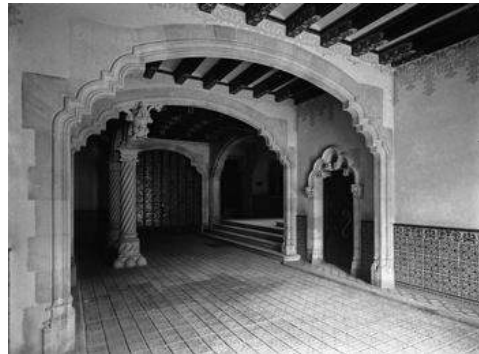
Fig. 166> Vestíbulo de la casa Amatller en 1902 (Fundació Institut Amatller d'Art Hispànic)
