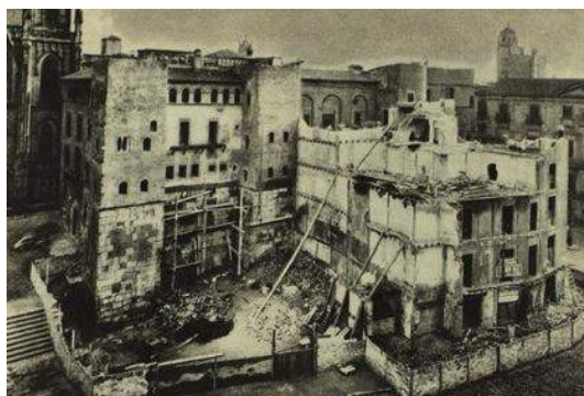
Fig. 274> Demolición de los edificios frente a la avenida de la catedral (Florensa 1958d, p.VI)
