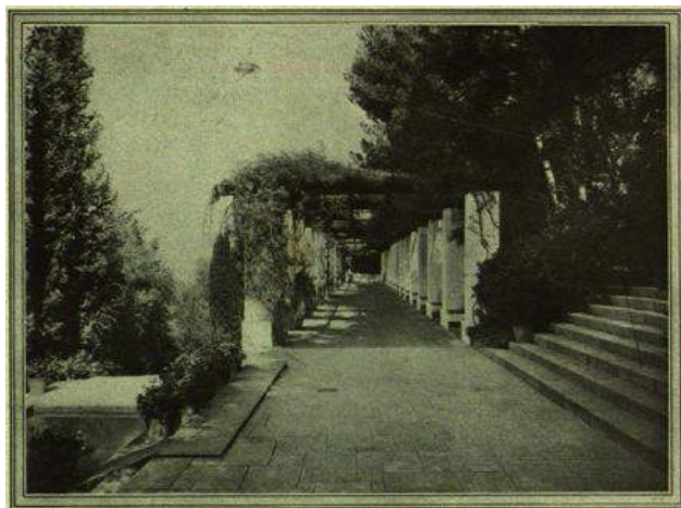
Fig. 216> Pérgola del parque Laribal en Montjuïc, bajo la pérgola la superficie del suelo se pavimenta con losas cerámicas, también utilizadas para la construcción de los bancos, para el tramo central que coincide con las escaleras se utiliza piedra natural (Foto Sport. D'ací i d'allà nº28, 1929-12, p.109 i 97)
