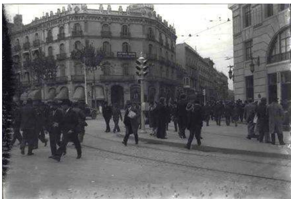
Fig. 199> Paso de peatones en portal del Àngel con Fontanella (Brangulí.1929-1930. ANC)
