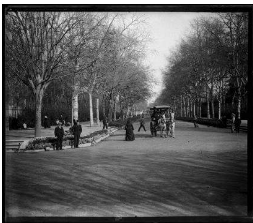
Fig. 234> Paseo central del parque de la Ciutadella, pavimentado con macadam asfáltico en 1926 (Borrás. AFCEC)
