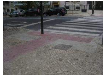
Fig. 561> Paso de peatones en la Rua Alves Redol, construido según modelo normalizado
