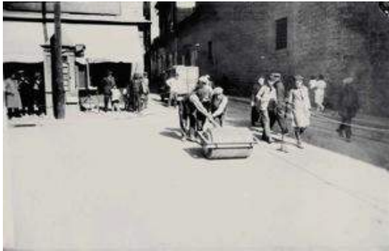
Fig. 179> Trabajo de apisonado del macadam mediante la utilización de un rodillo manual (Brangulí. 1920-1930. ANC)
