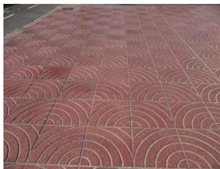
Fig. 366> Detalle pavimentación plaza Espanya
