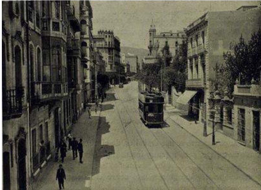
Fig. 196> Avenida Republica Argentina. Pavimento Hormigón mosaico (Ayuntamiento de Barcelona 1926, p.26)
