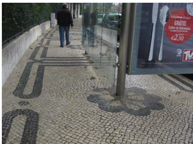
Fig. 558> La colocación de elementos en el espacio urbano se realiza sin tener en cuenta los mosaicos de las aceras, tal como podemos ver en la instalación de la marquesina de la Praça da Estrela
