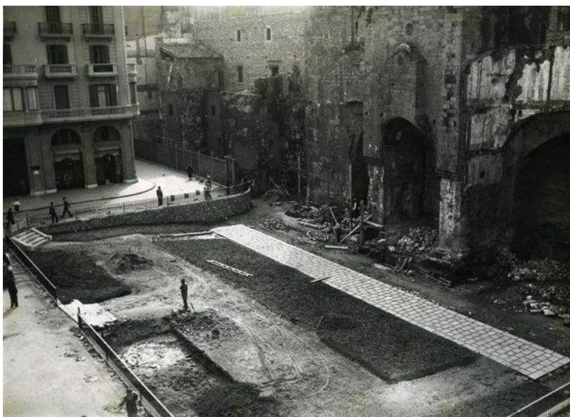
Fig. 265> Construcción del jardín junto a la muralla en a plaza Berenguer el Gran (Pérez de Rozas. 1935. AFB)
