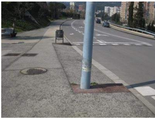
Fig. 425> Pavimentación de las aceras con asfalto, detalle Vado para peatones
