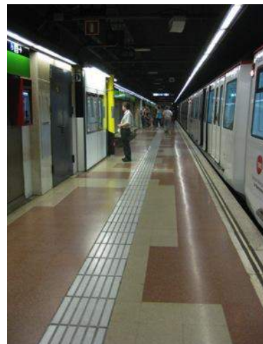
Fig. 379> Pavimento anden estación Les Corts
