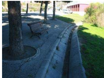
Fig. 428> Cuneta de desagüe con piezas de hormigón prefabricado
