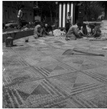
Fig. 536> Pavimentación Av. Liberdade junto salida Metro Marques de Pombal 1959 (Benoiel 1959. AMLSB-F)
