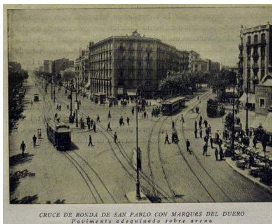
Fig. 191> Avenida Paralel con Ronda Sant Pau, pavimento adoquinado sobre arena (Ayuntamiento de Barcelona 1926, p.30)
