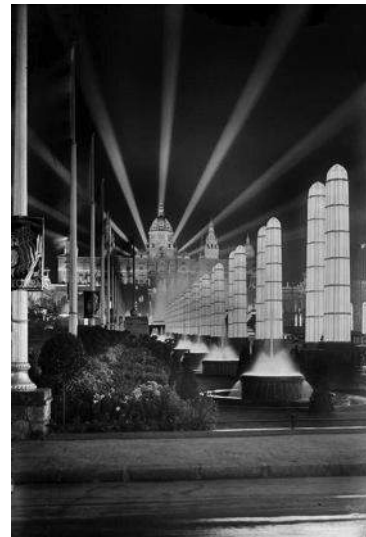
Fig. 225> Iluminación de la avenida principal (Casas. 1929-1930. ANC)
