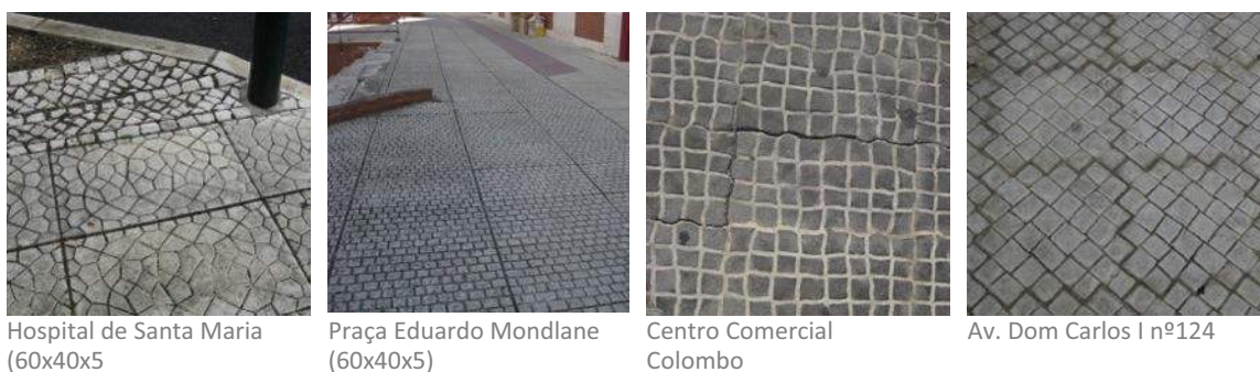
Fig. 562> Distintos tipos de calçada prefabricada con losas de hormigón
