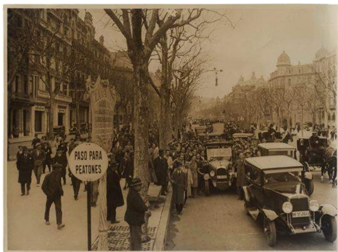
Fig. 206> El paseo de Gràcia es el primer paseo peatonal pavimentado con asfalto monolítico en Barcelona en 1924 (Segarra Plana. 1930. AFB)
