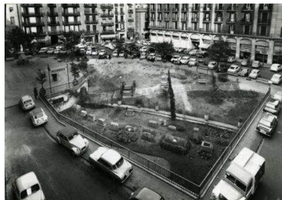
Fig. 271> Vista general de la plaza (Ribera. 1967. AFB)
