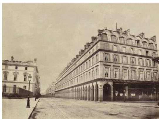
Fig. 46> Imagen de la Rue de Rivoli , pavimentada con macadam y cunetas de adoquines (Plaut 1865, lámina 19)
