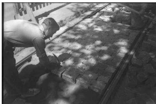
Fig. 193> Obras de adoquinado entre los railes del tranvía (Brangulí. 1952. ANC)
