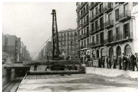
Fig. 308> Obras de cobertura de la zanja de la calle Aragón (Brangulí. 1961. AFB)
