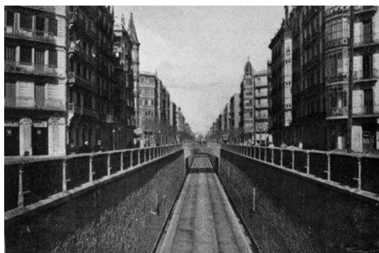
Fig. 307> Zanja de las vías del tren por la calle Aragón (Cuyàs. 1913. ICC)
