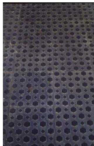
Fig. 386> Detalle pavimento antideslizante (Arxiu Escofet)
