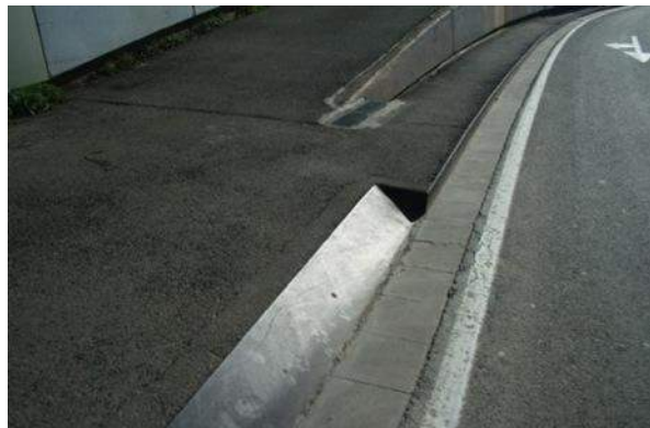
Fig. 426> detalle bordillo y vado para vehículos construidos con pletina de acero corten.
