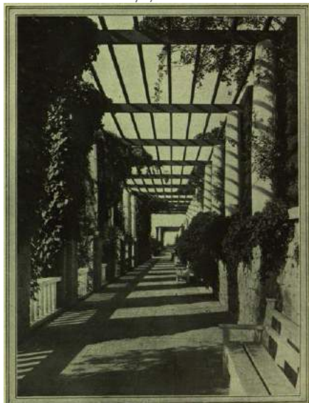
Fig. 216> Pérgola del parque Laribal en Montjuïc, bajo la pérgola la superficie del suelo se pavimenta con losas cerámicas, también utilizadas para la construcción de los bancos, para el tramo central que coincide con las escaleras se utiliza piedra natural (Foto Sport. D'ací i d'allà nº28, 1929-12, p.109 i 97)
