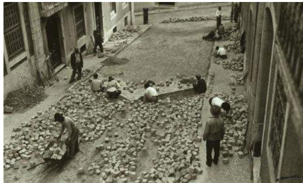
Fig. 513> Obras de pavimentación en la Rúa da Emenda con cubos de granito (Portufal 1935. AMLSB-F)
