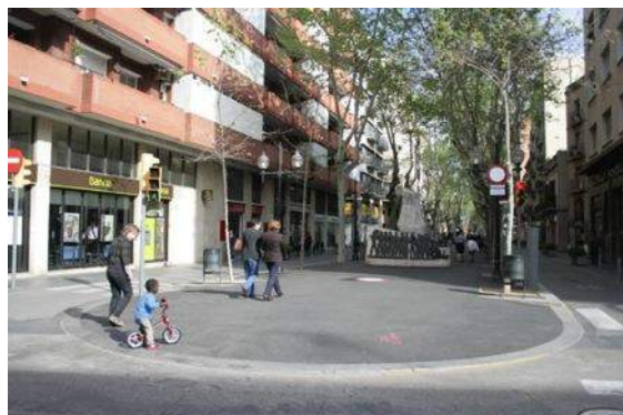
Fig. 594> Re-asfaltado de la Rambla del Poblenou. Los vecinos paralizaron las obras de asfaltado de la Rambla en 2013
