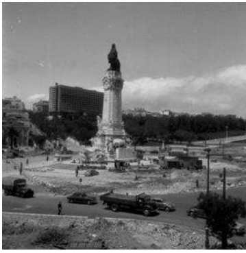
Fig. 535> Obras do metropolitano (Benoiel 1959. AMLSB-F)
