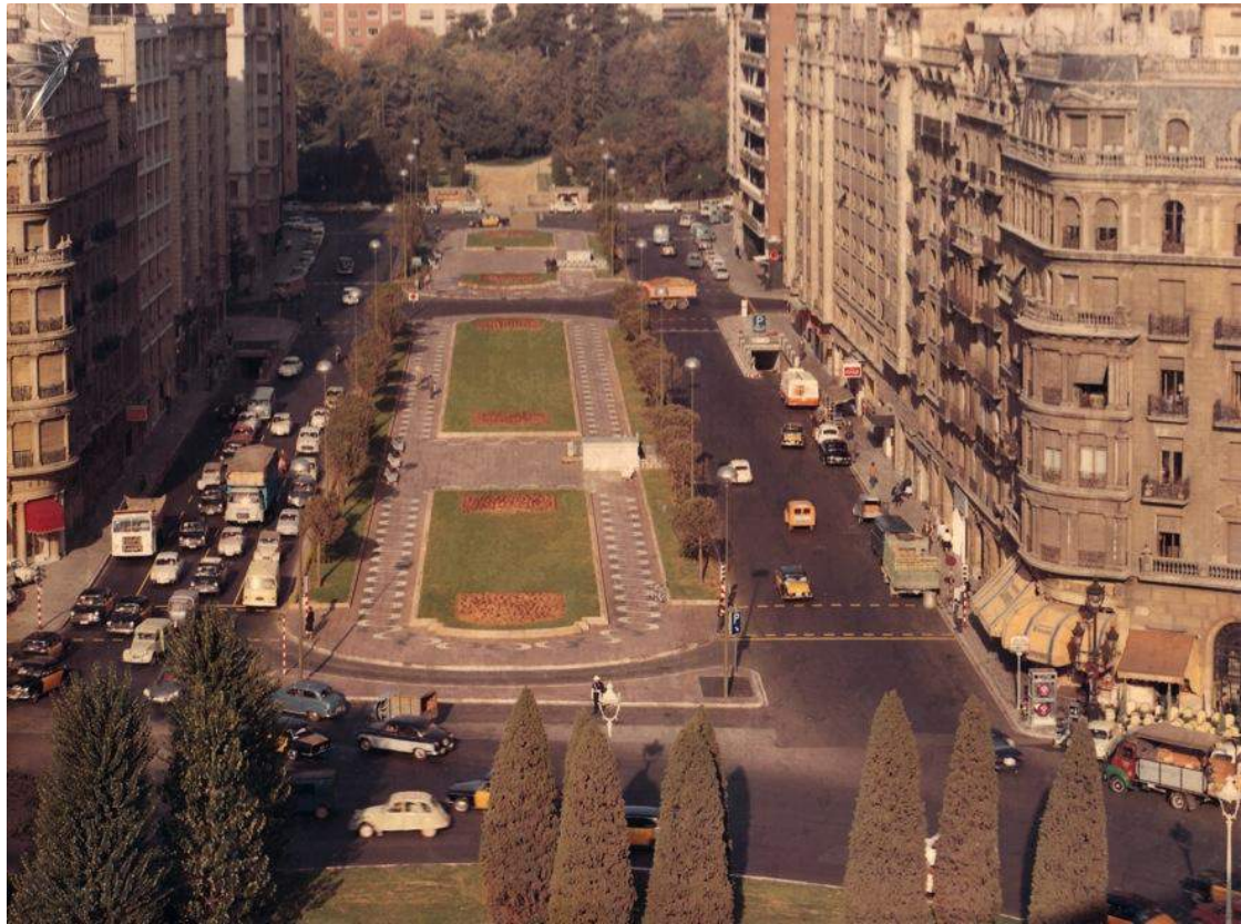
Fig. 335> Avinguda Pau Casals tras las obras de nueva pavimentación (Fabregas. Arxiu Escofet)
