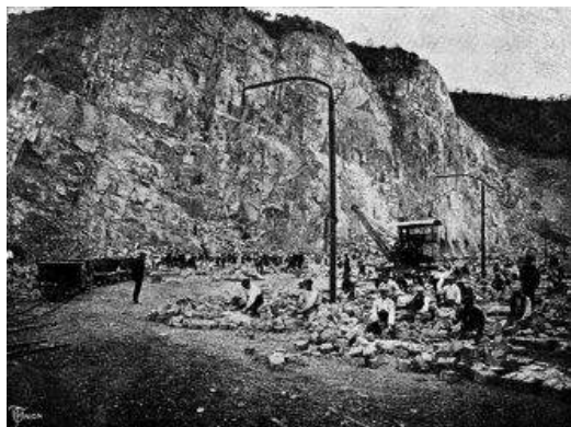
Fig. 61> Preparación de adoquines en la cantera Musol (Faura 1918, p.89)
