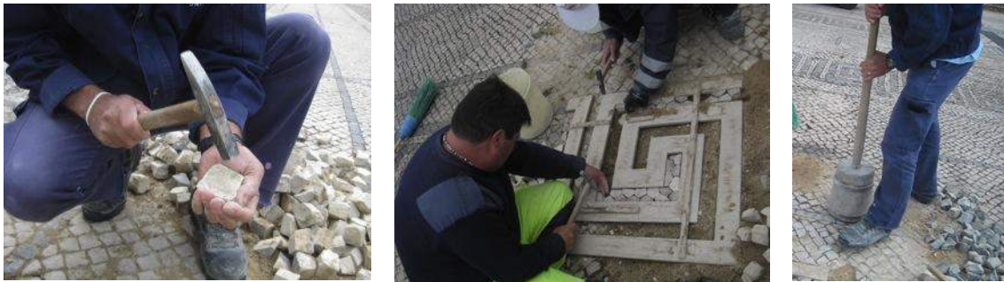
Fig. 477> Proceso de trabajo de los calceteiros municipales en la reparación de un mosaico en el parque Eduardo VII
