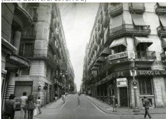
Fig. 370> Calle Jaume I pavimentado con Vibrazo Relieve (Czibor. 1980. AFB)
