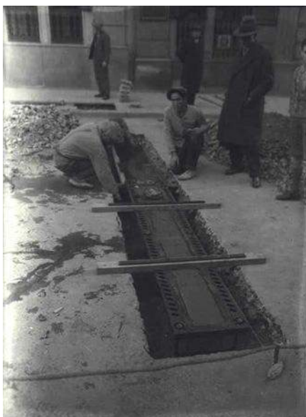
Fig. 203> Instalación de un detector automático para el semáforo (Casas i Galobardes. 1932-1933. ANC)
