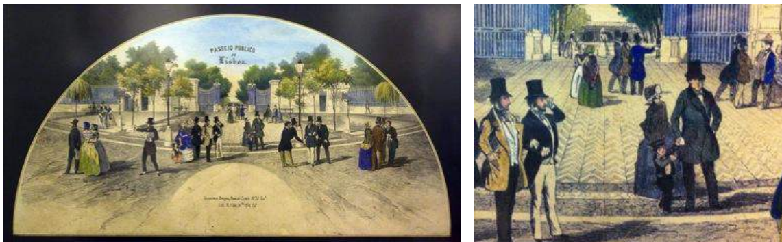
Fig. 485> Grabado coloreado para la decoración de un abanico donde se puede ver la calçada construida en la entrada al Passeio Público en 1848 (Museu da Cidade, CML)
