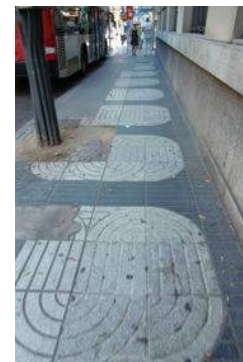
Fig. 369> Pavimento existente en Balmes
