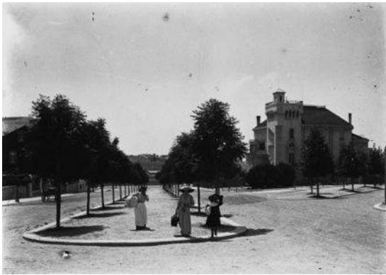
Fig. 515> Paseo central en la avenida Cinco de Outubro pavimentado con macadam (Benoliel 1908. AMLSB-F)
