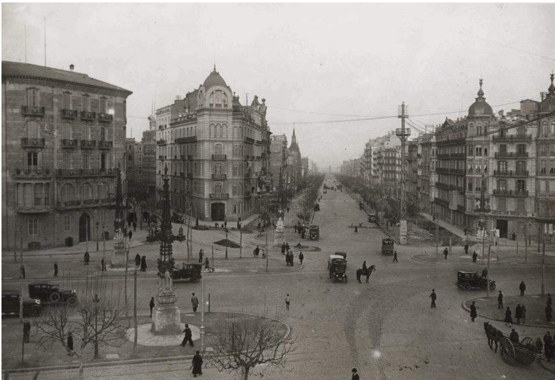
Fig. 130> La ampliación del paseo central de la Diagonal mantiene la base de mosaico alrededor de las farolas, integrada al mismo nivel que el paseo (Autor desconocido. 1930-1932. AFB)
