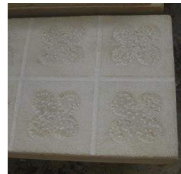
Fig. 167> Las obras de restauración de la casa Amatller en 2013 muestran que el material utilizado para la pavimentación del vestíbulo no son losetas de cemento sino piedra natural de Montjuïc tallada
