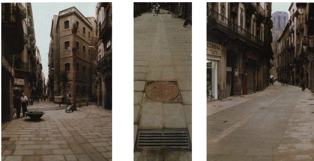
Fig. 414> Pavimentación a nivel en las calles de Ciutat Vella (1989) Artigues, J.; Barjuan, J.; Roig, M. (Ajuntament de Barcelona 1993, p.112)
