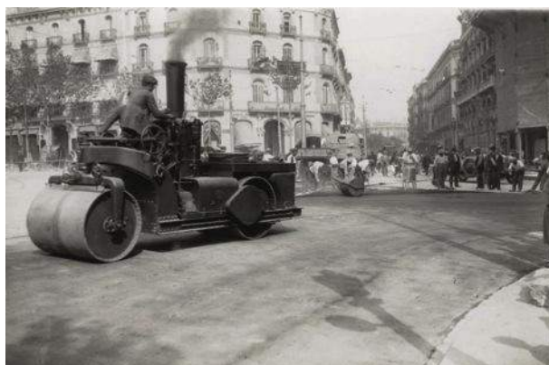
Fig. 230> Obras de asfaltado de las calzadas alrededor de la plaza Catalunya (Domínguez. 1927. AFB)
