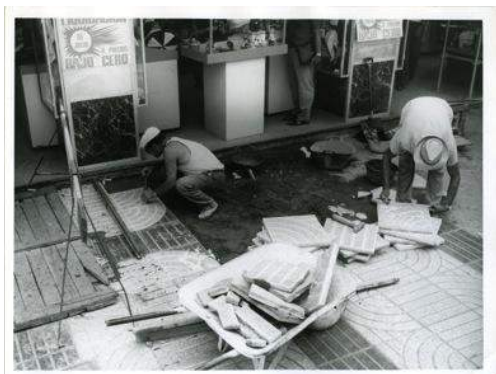
Fig. 367> Reparaciones del pavimento de Pelai (Saenz Guerrero. 1973. AFB)
