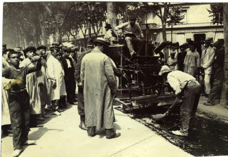
Fig. 116> Alquitranado del paseo de Gràcia realizado en 1908 tras el ensayo en las Ramblas (Ballell. 1908. Asfaltant el Passeig de Gràcia. AFB)
