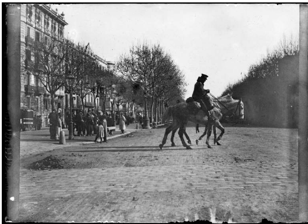
Fig. 84> Paso adoquinado en el paseo de Gràcia, los adoquines se disponen perpendiculares a la calzada (Aguirre. 1888-1910. AFCEC)
