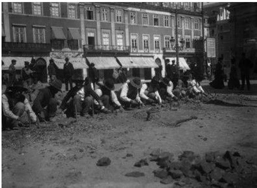
Fig. 512> Calceteiros pavimentando calzada con empedrado “á portuguesa” utilizando piedras de basalto irregular (Benoliel 1907-04. AMLSB-F)
