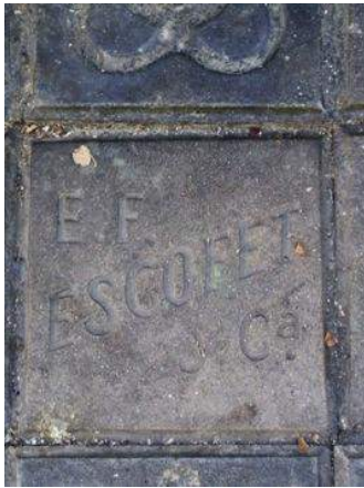
Fig. 162> Loseta con el nombre del fabricante de las baldosas
