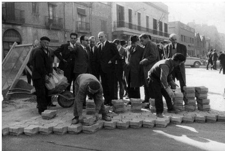
Fig. 303> Visita de Porcioles a las obras de pavimentación de Pere IV (Brangulí. 1966. AHPN)
