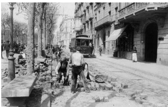
Fig. 192> Obras de colocación de carriles de tranvía en rambla de Catalunya (Brangulí. 1910-1920. ANC)
