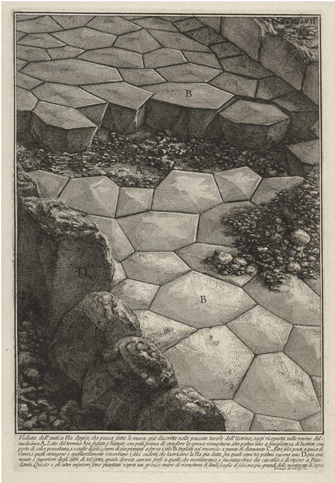
Fig. 4> Piranesi describe el sistema empleado para la construcción de la Via Appia (Piranesi. 1756. Veduta dell'antica via Appia. MET)
