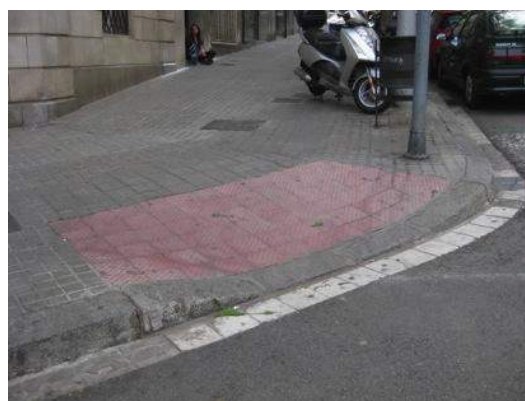
Fig. 405> Vado construido con losetas de cemento hidráulico de textura punteada, en cumplimiento con la ordenanza de 1979
