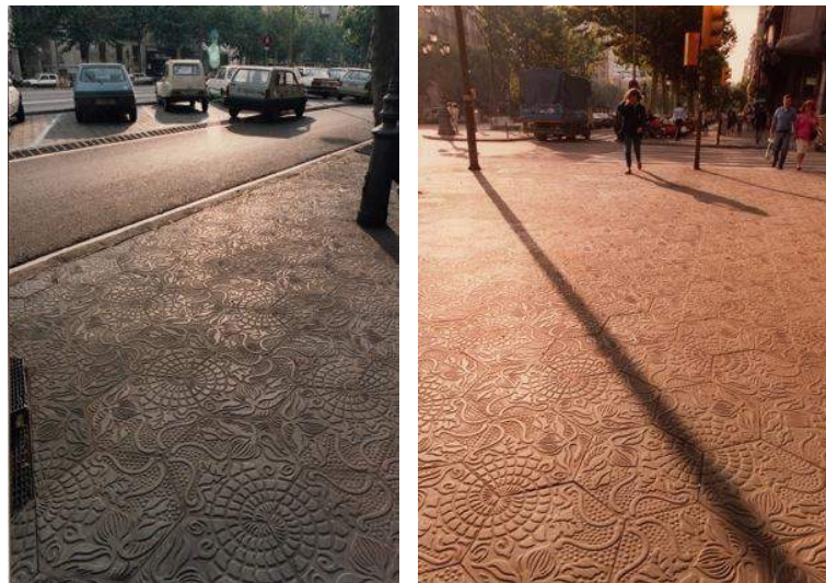
Fig. 355> Paseo de Gràcia pavimentado con losas Vibrazolít (Arxiu Escofet)
