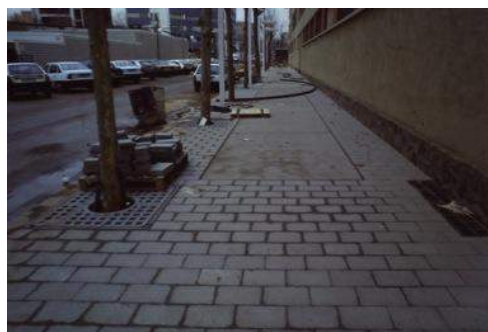
Fig. 436> Obras de urbanización de las aceras de la Vila Olímpica, con losas de 30x20x6 textura a maquina granallado y cara vista de composición granítica
