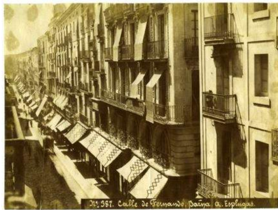
Fig. 78> Tras los ensayos de piedra, en la calle Ferran también será en 1905 el asfalto encauchado sistema Candemberg (Esplugas. 1880. AFB)
