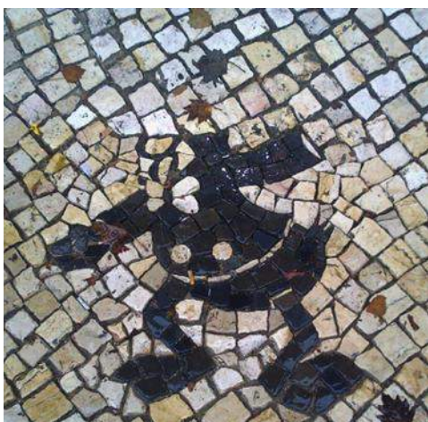
Fig. 557> La reconstrucción de mosaicos por operarios no especializados. Consecuencias visibles en la reconstrucción de la cabeza del Pato Donald de la Av. de Roma nº 10
