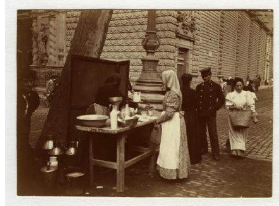
Fig. 95> A pesar de las expectativas puestas en el adoquinado de madera surgirán varias críticas hacia este material por su efecto resbaladizo, precio elevado y acumulación de humedad (Ballell. 1907-1908 AFB)
