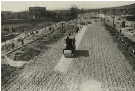
Fig. 185> Trabajos de compactación del macadam antes de proceder a la lechada con cemento y revestimiento de alquitrán (Autor desconocido. 1925-1932. AFB)
