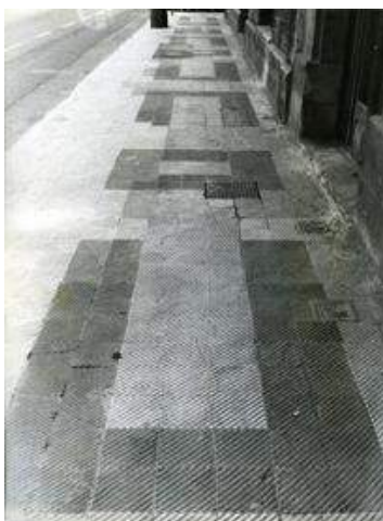
Fig. 312> Losetas lisas de la calle Aragó (Víctor. 1975. AFB)
