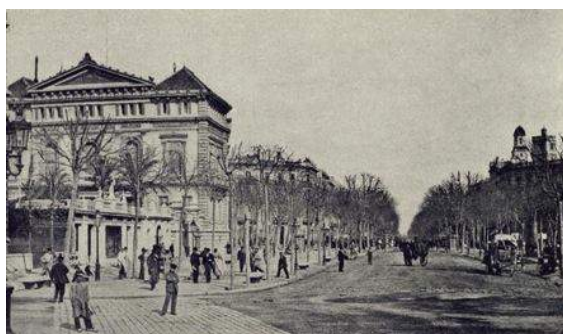
Fig. 85> Paso adoquinado en Gran Vía entre rambla Catalunya y paseo de Gràcia (Rius. 1890. En Cuadernos de Arquitectura y Urbanismo 1974, nº101, p.5)
