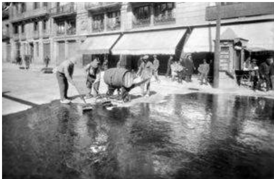
Fig. 181> Proceso de vertido del alquitrán (Brangulí. 1920-1930. ANC)
