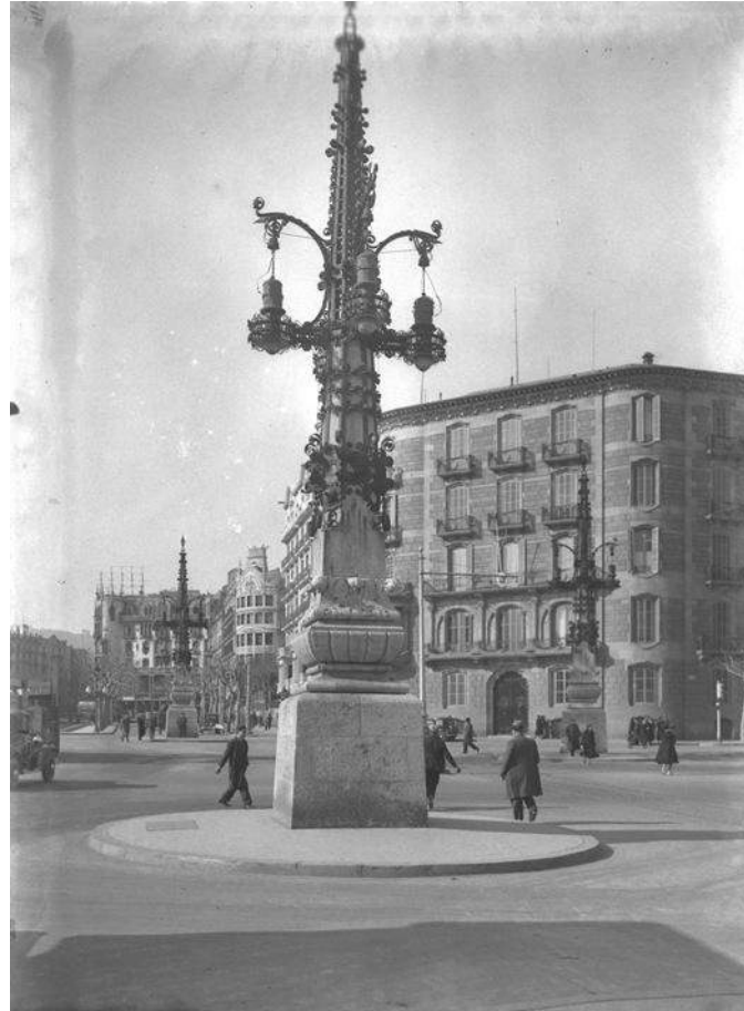
Fig. 131> Farola de Pere Falqués para el cruce de la Diagonal y paseo de Gràcia, actualmente situadas en la avenida Gaudí (Brangulí. 1919-1930. ANC)
