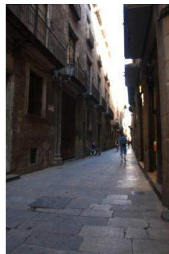
Fig. 256> Estado actual de la calle Montcada pavimentado a nivel
