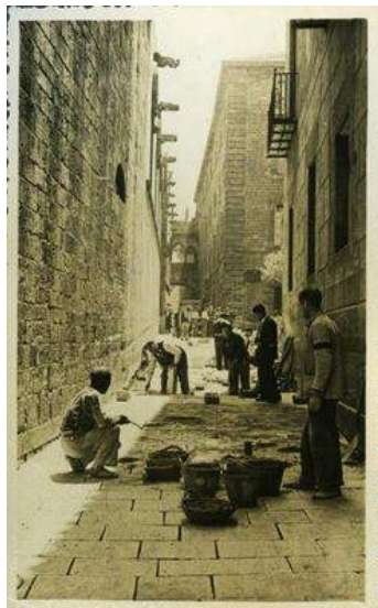
Fig. 250> Obras de pavimentación (Autor desconocido. 1951-1952. AFB)
