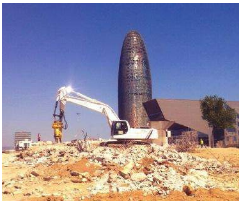
Fig. 577> La construcción de la plaza de les Glòries inicia en 2014 el derribo del tambor viario inaugurado en 1992
