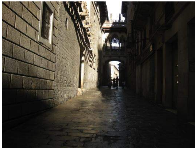
Fig. 587> El asfalto, las losetas y adoquines desaparecen de las calles del barrio histórico para recuperar los empedrados de piedra de Montjuïc utilizados a mitades del s.XIX
