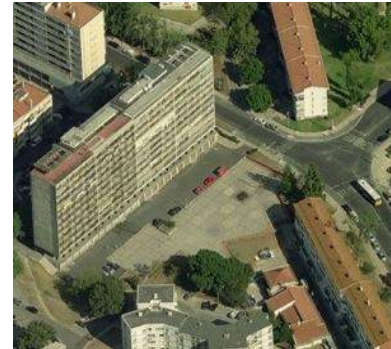
Fig. 540> Plaza peatonal junto a la Rúa Alferes Barrilaro, donde se combina la utilización de calçada portuguesa y adoquín cerámico
