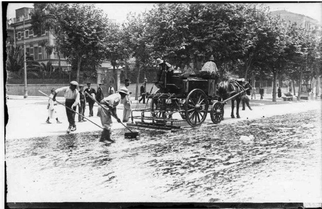
Fig. 117> Trabajos de alquitranado en el paseo de Gràcia realizados periódicamente para mejorar las superficies macadamizadas y reducir el polvo (Brangulí. Enquitranament del Passieg de Gràcia. 1911. ANC)
