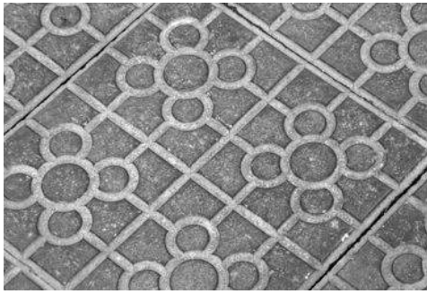
Fig. 581> A diferencia de las de Barcelona, las baldosas de Bilbao tiene 60cm y contiene 4 flores, con surcos para reducir la acumulación de agua
