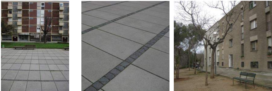
Fig. 391> Estado actual del pavimento de Montbau, renovado en 2009 por losas de hormigón armado
