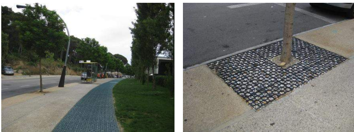
Fig. 457> En can Caralleu (2008) se ensaya la colocación de pavimentos permeables, mediante la utilización del sistema de Celdas Atlantis
