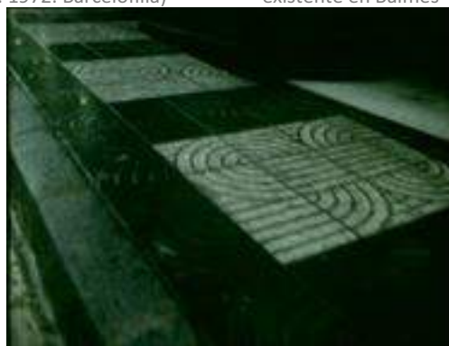
Fig. 371> detalle del pavimento de la calle Jaume I (Ballesteros 1971)
