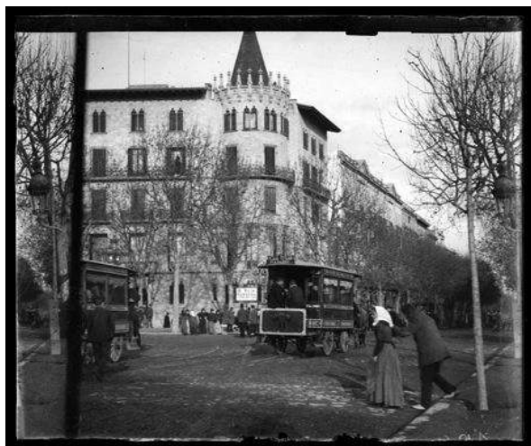
Fig. 82> Paso adoquinado en la ronda Sant Pere para facilitar el cruce de los peatones por las calzadas afirmadas (Bartomeus. 1897.1930. AFCEC)
