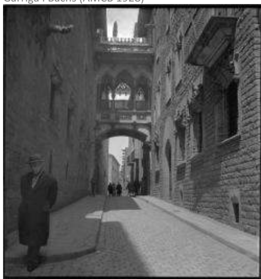
Fig. 248> Calle del Bisbe con pavimentación de adoquines y aceras de losas (Cuyàs. ICC)
