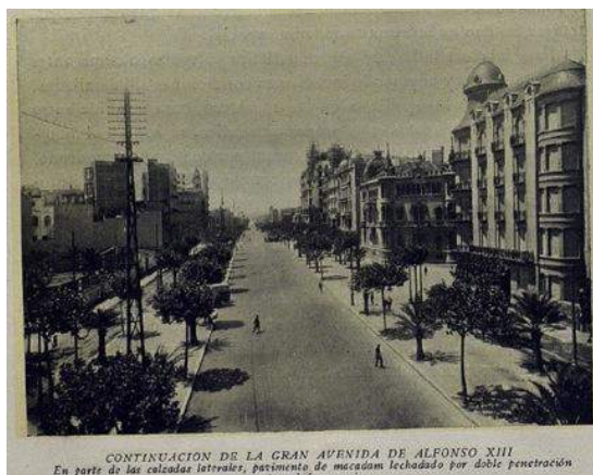
Fig. 184> Avenida Diagonal, pavimentada con macadam lechado por doble penetración (Ajuntament de Barcelona 1926, p.46)
