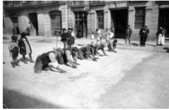
Fig. 180> Hombres limpiando la superficie, retirando las piedras para mejorar la adherencia (Brangulí. 1920-1930. ANC)
