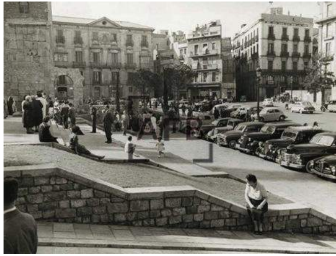
Fig. 277> Escaleras frente a la catedral tras la reforma de la avenida (Pérez de Rozas. 1958. AFB)
