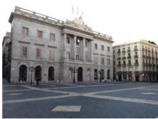
Fig. 282> La plaza Sant Jaume tras las obras de pavimentación monumental
