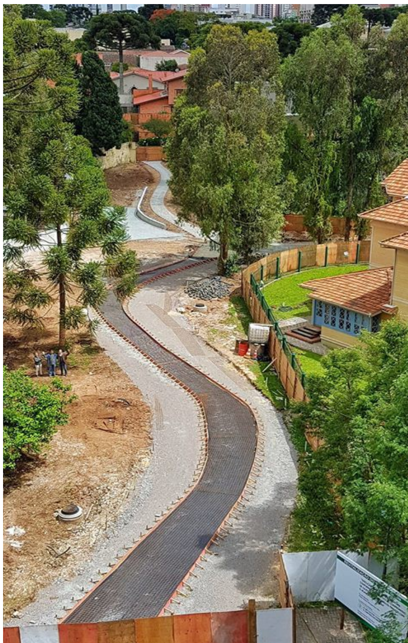
Figura 6: Via de emergência: exigência do corpo de bombeiros para funcionar o empreendimento – ônus que fica suportado por área pública oriunda do parcelamento da matrícula e subsequente doação ao poder público. Fonte: “Salvemos o Bosque da Casa Gomm” facebook
