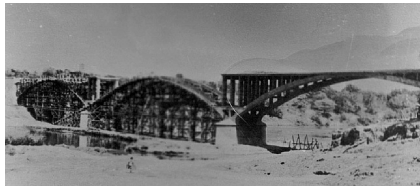
Ponte JK em construção - Década 1950
