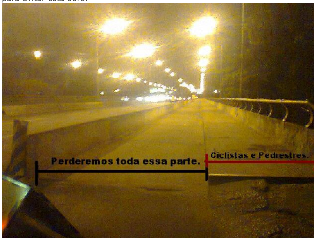
Alargamento da Ponte Juscelino Kubitschek
