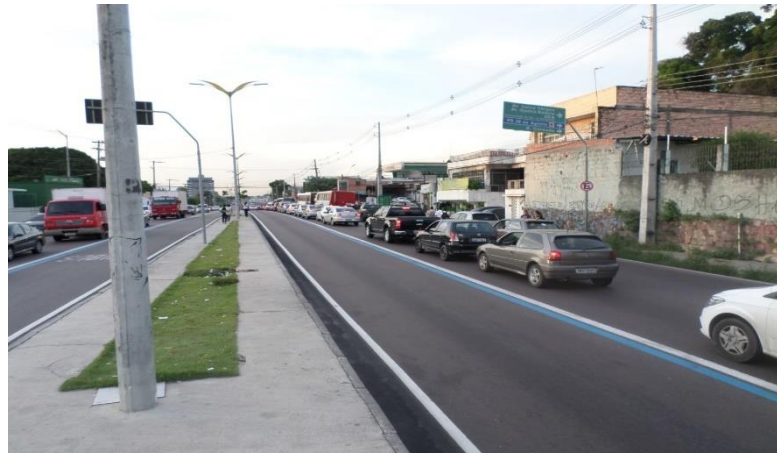
Figura 3 - Faixa exclusiva de ônibus ao canteiro central - Manaus.
