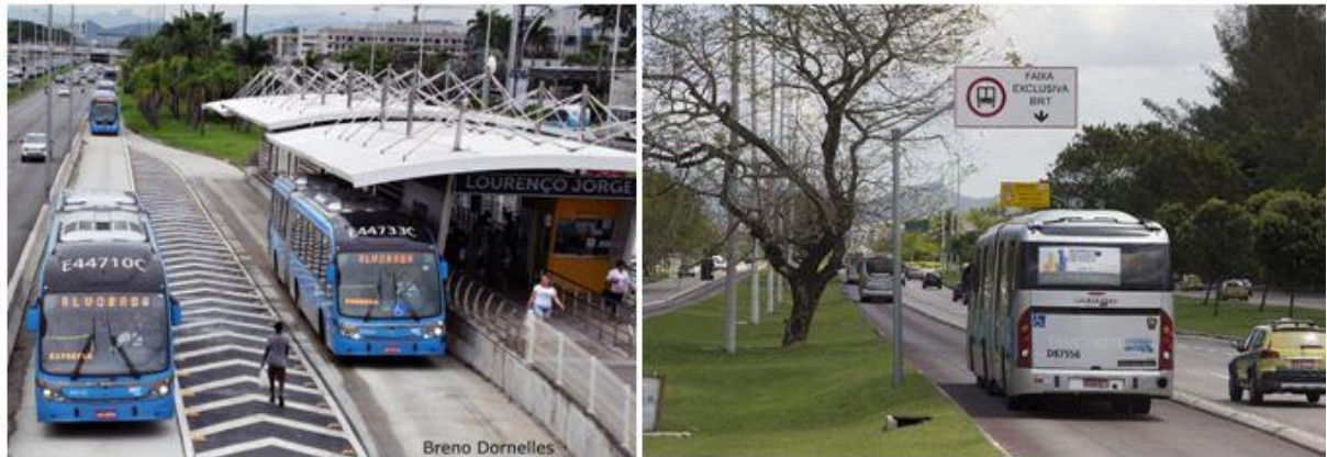
Figura 9 - BRT em operação no Rio de Janeiro.
