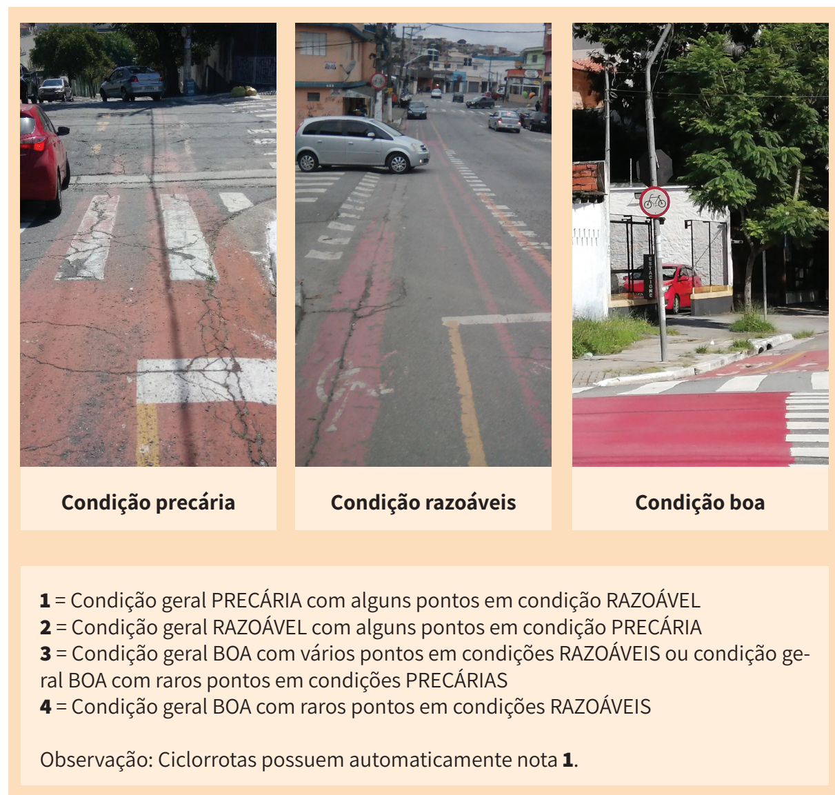
Figura 11. Avaliação das condições de sinalização horizontal em cruzamentos em todas as estruturas. Fonte: Elaboração própria (2022).
