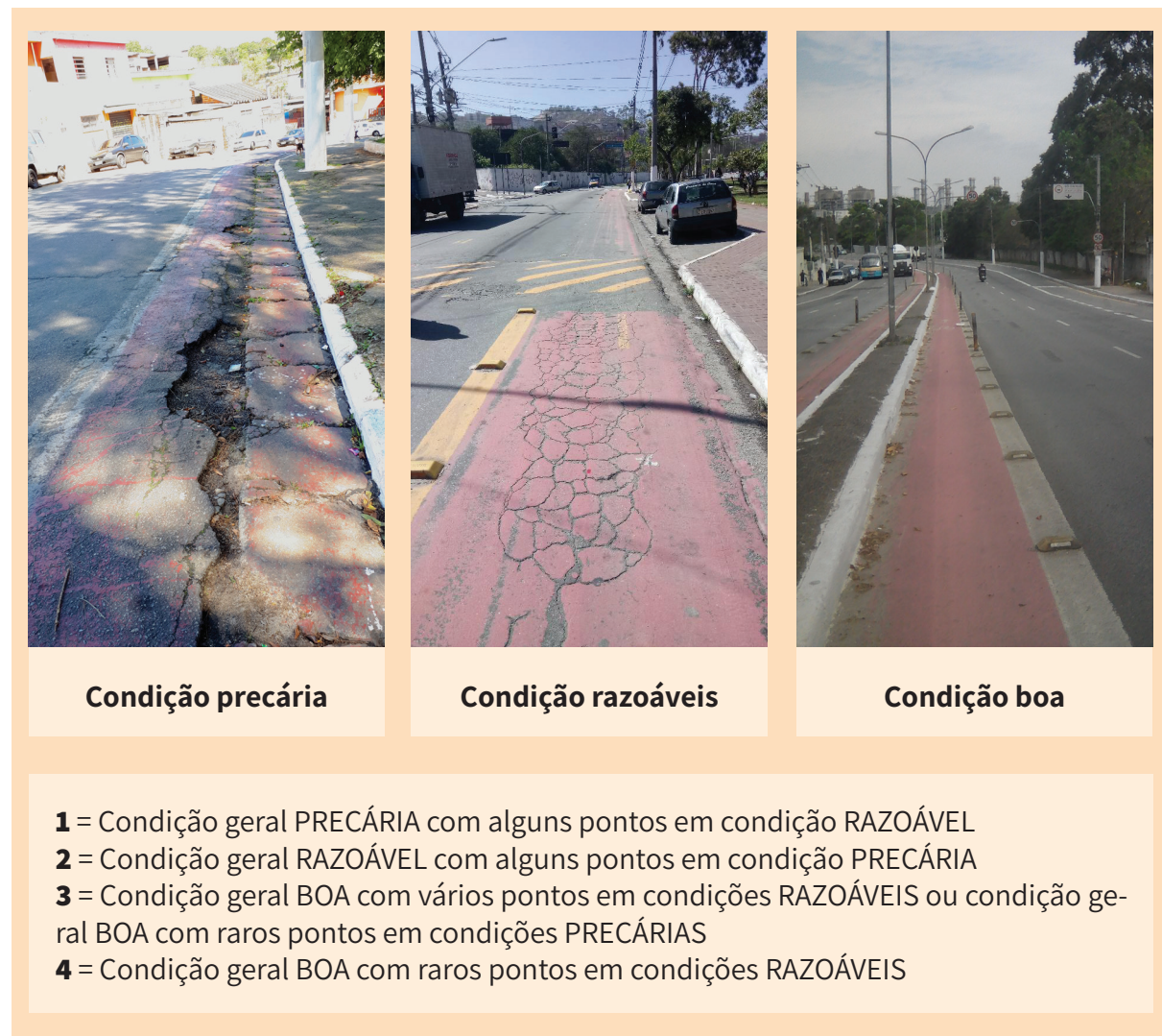
Figura 10. Avaliação das condições de pavimento em todas as estruturas. Fonte: Elaboração própria (2022).
