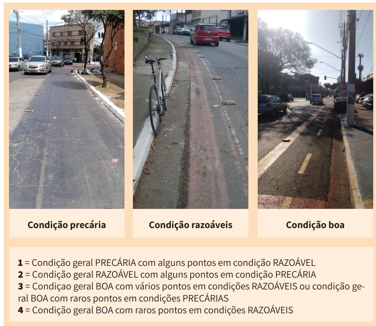
Figura 9. Avaliação das condições de pintura em todas as estruturas. | Fonte: Elaboração própria (2022).
