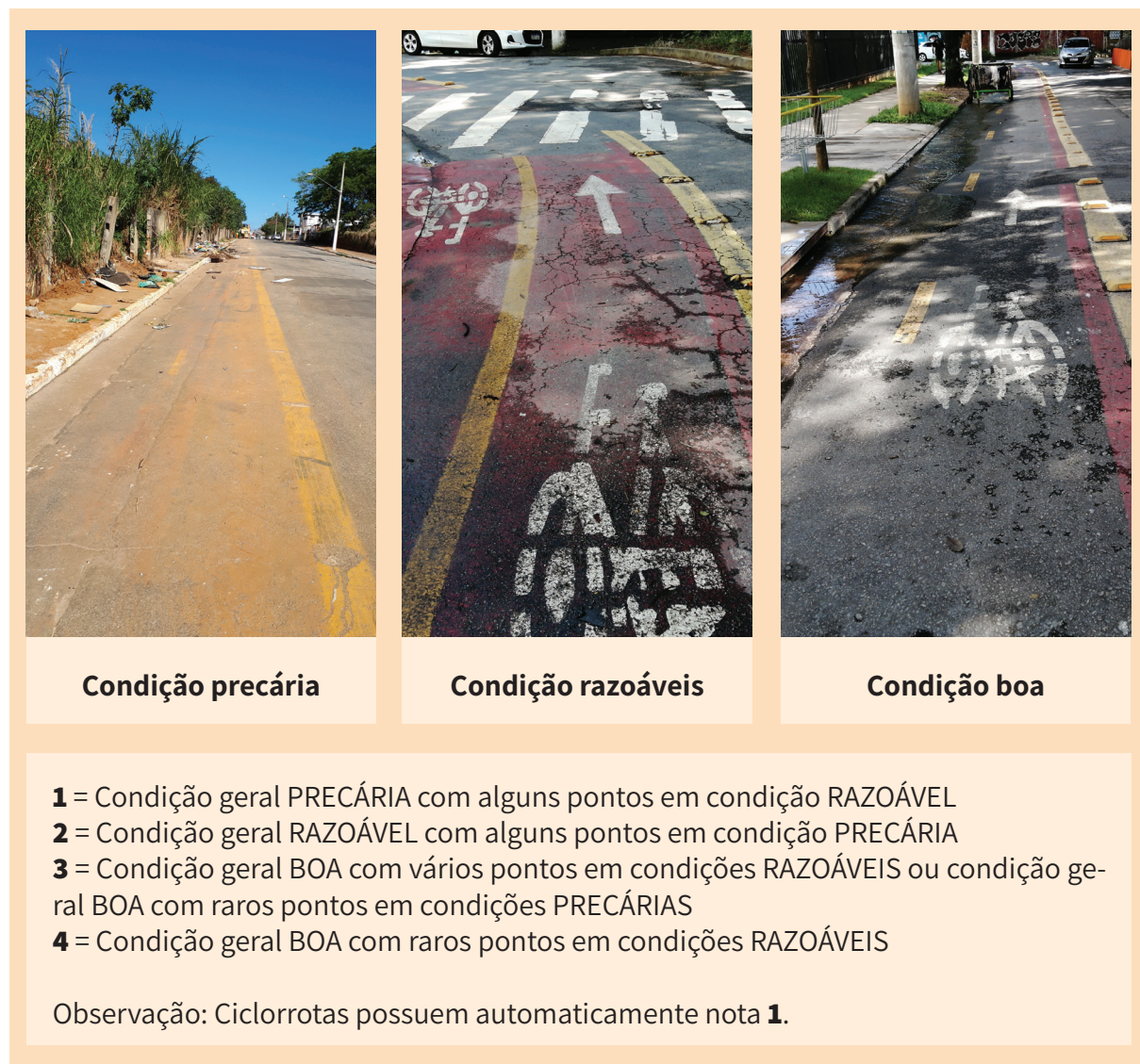
Figura 7. Avaliação para elementos de proteção em ciclofaixas. | Fonte: Elaboração própria (2022).
