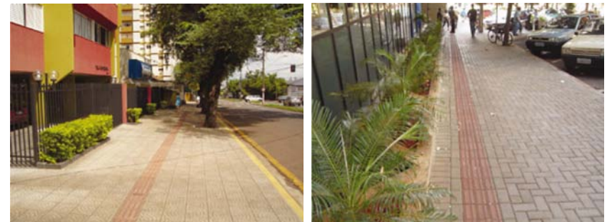
Figura 14 Calçada em cimento alisado e em petit pavet com faixa tátil em ladrilho hidráulico
