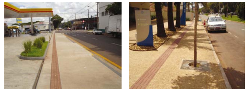
Figura 14 Calçada em cimento alisado e em petit pavet com faixa tátil em ladrilho hidráulico
