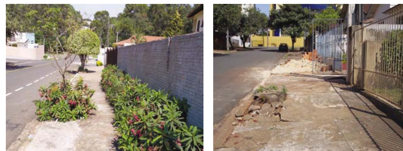
Figura 1 Calçadas inadequadas em Londrina: arborização, buracos, material de construção e degraus
