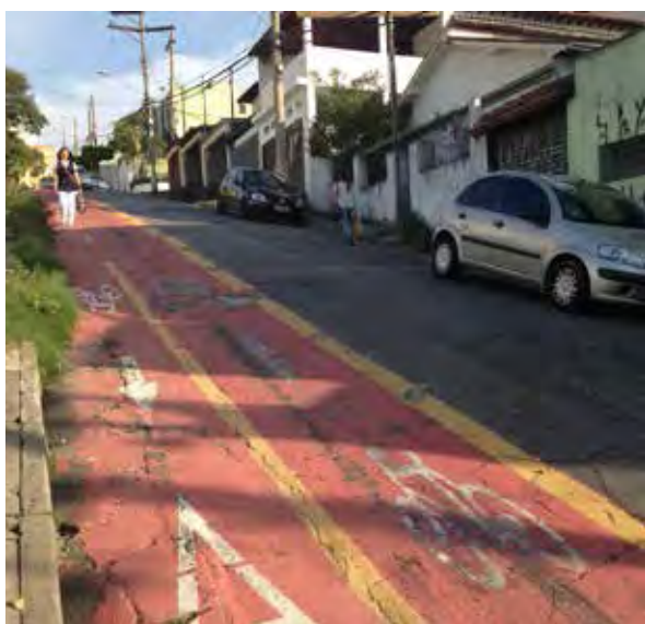
Via com topografia desfavorável R. Milton de Souza Quintino, Zona Oeste
