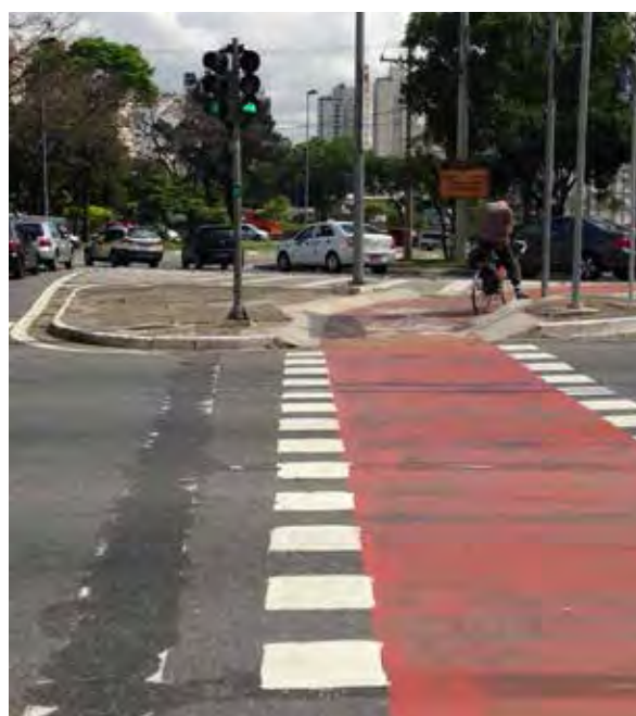
Posicionamento adequado de semáforo para ciclistas Alça de acesso à Ponte da Casa Verde, Centro
