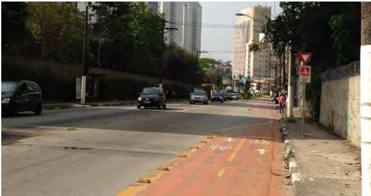
Placas indicativas/de advertência para condutores de ônibus em tamanho inadequado R. Dr. Luiz Migliano, Zona Oeste
