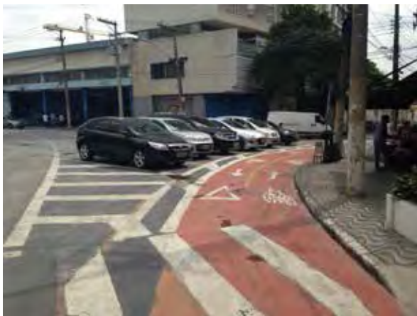
Ciclovia segregada com buffer (canteiro central fictício) e estacionamento de veículos perpendicular R. Rio Bonito, Centro
