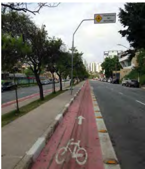
Travessia de ciclistas indicada antecipadamente e com boa visibilidade, através de sinalização vertical Av. Eng. Caetano Álvares, Zona Norte
