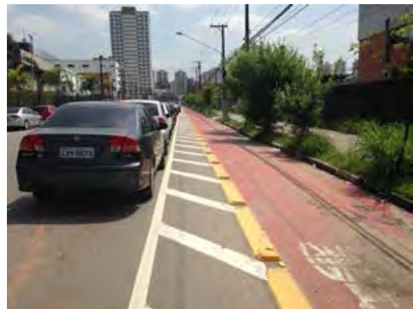
Ciclovia segregada com buffer (canteiro central fictício) e estacionamento de veículos em paralelo R. Maestro Gabriel Migliori, Zona Norte
