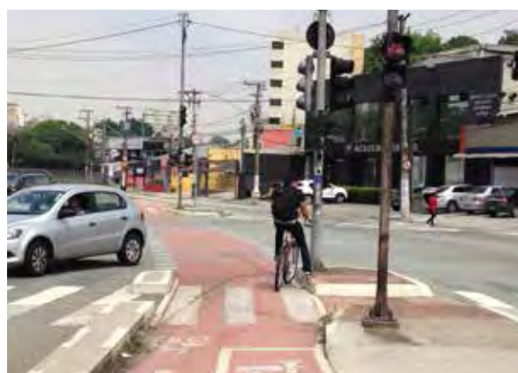
Semáforo de pedestres adaptado ao uso para ciclistas Av. Eliseu de Almeida, Zona Oeste
