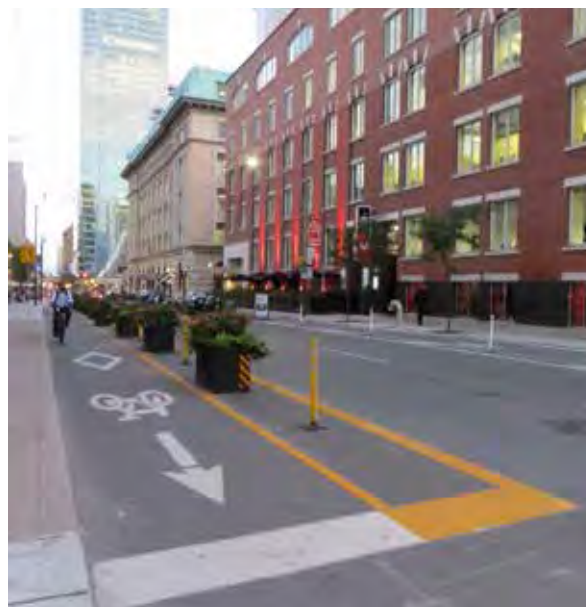
Ciclovía unidirecional segregada por mobiliário e buffer Toronto, Canadá
