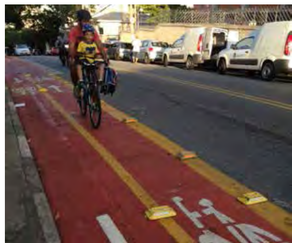
Ciclofaixa bidirecional com largura inadequada R. Jaguaré, Zona Oeste
