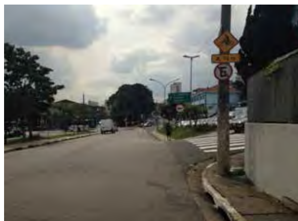
Sinalização de advertência operando como sinalização indicativa R. Ararituaba, Zona Norte
