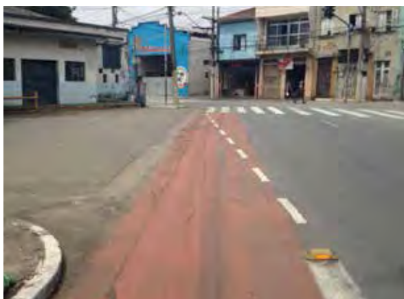
Falta de continuidade e de sinalização do percurso R. Araguaia, Zona Leste
