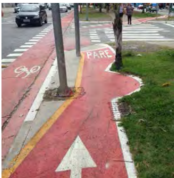
Estrangulamento e desvio feitos de forma inadequada Av. Eng. Caetano Álvares, Zona Oeste
