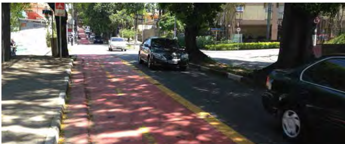
Via atraente, com arborização agradável Av. Bologna, Zona Oeste
