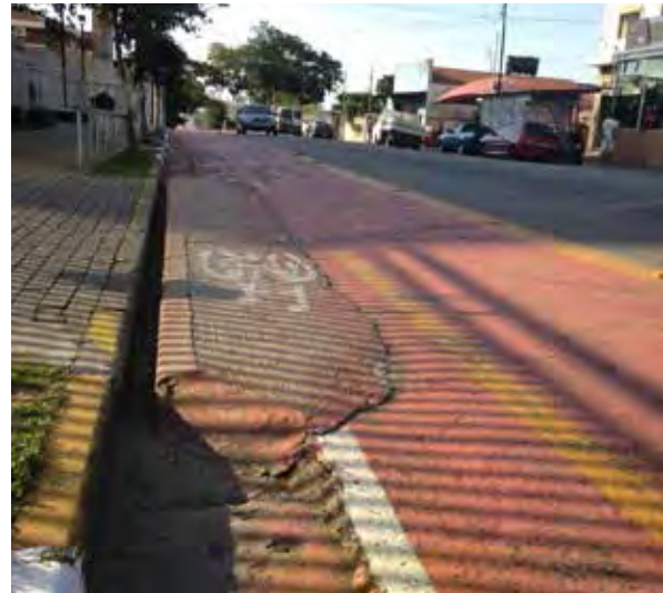
Rampa de acesso à garagem na ciclofaixa R. Octacílio Tomanik, Zona Oeste
