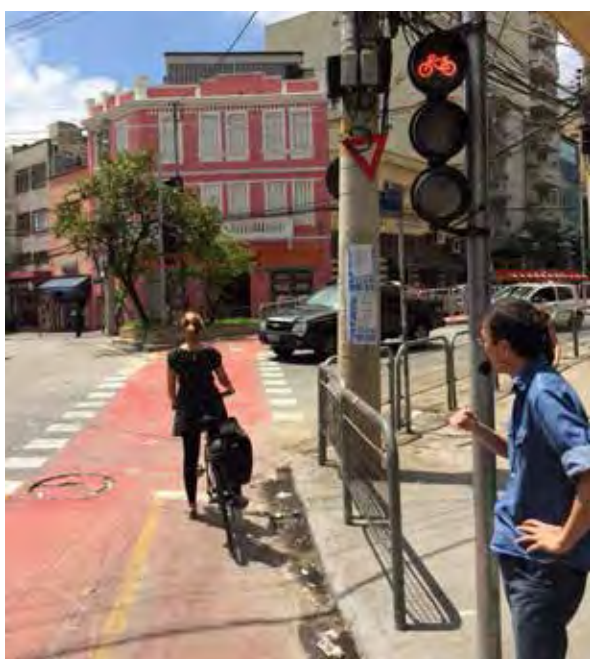
Posicionamento inadequado de semáforo para ciclistas R. Silva Pinto, Zona Norte
