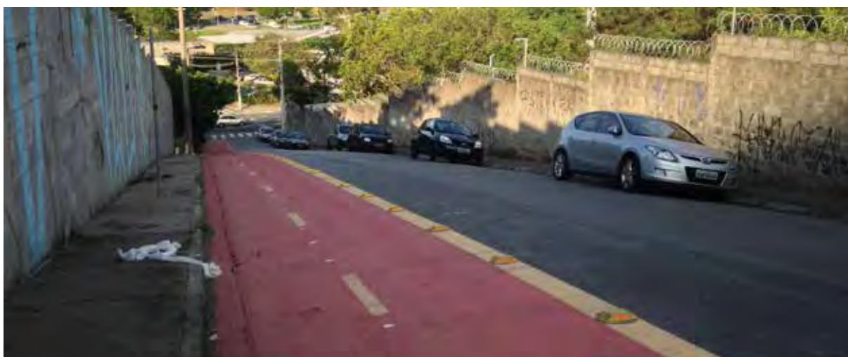
Via com condições precárias de segurança (falta iluminação, uso do solo pobre, muros dos dois lados) R. Valson Lopes, Zona Oeste
