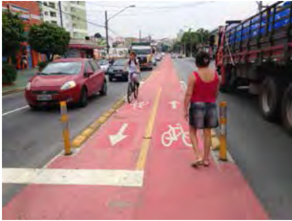
Ciclofaixa bidirecional com segregação insuficiente Av. Min. Petrônio Portella, Zona Norte
