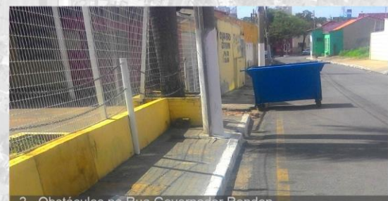
2 - Obstáculos na Rua Governador Rondon Diferentes tipos de obstáculos foram encontrados em diversas vias, como: postes de iluminação, sinalização vertical entre outros
