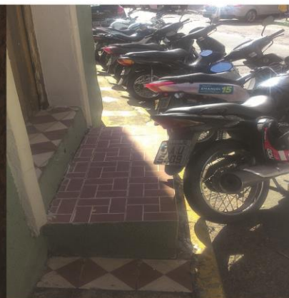
Rua 12 de Outubro - Escadaria na calçada, obstruindo a passagem de pedestres com mobilidade reduzida, além de estacionamento na via
