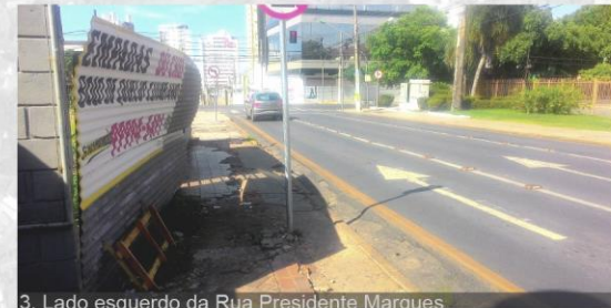
3. Lado esquerdo da Rua Presidente Marques Na imagem acima percebe-se a má qualidade do pavimento somado a outros obstáculos como placas de sinalização e entulho
