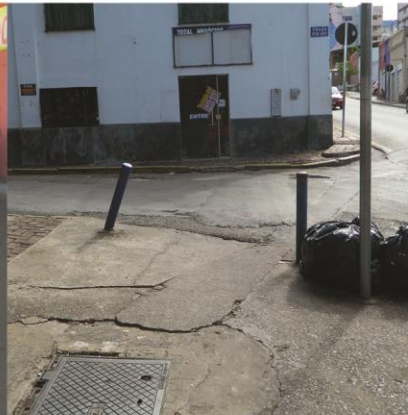
Rua Barão de Melgaço - estacas de ferro para proteção
