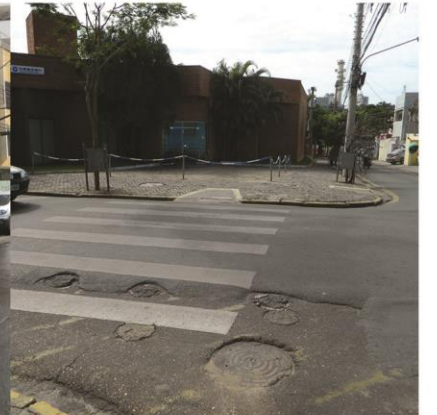
Rua Campo Grande - faixa de pedestre
