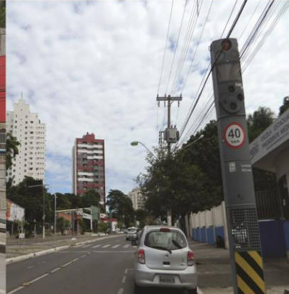
Av. Mato Grosso - Redutor de Velocidade e faixa de pedestres
