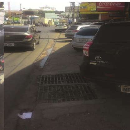
Av. Tenente Coronel Duarte - Bueiro como obstáculo, em conjunto com o estacionamento de veículos.
