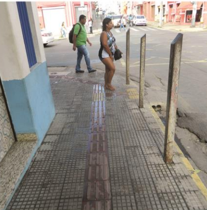
Av. Isaac Póvoas - Estacas de madeira utilizadas para proteção contra os veículos
