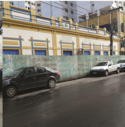
Rua Barão de Melgaço - Edifício em obras sem calçada, retirando toda a proteção do pedestre
