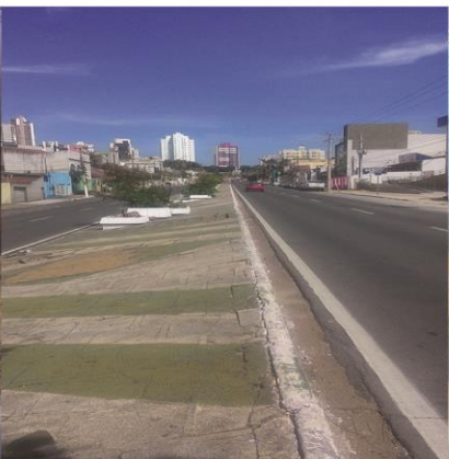
Av. Mato Grosso - Canteiro no eixo da via de aproximadamente 5 metros
