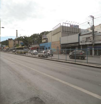
Av. Tenente Coronel Duarte - Impedi- mento para que o pedestre cruze nesses pontos através de cerca de arame
