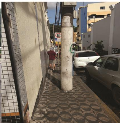
Travessa Avelino Siqueira - Poste de Iluminação impedindo a passagem. Foto: Renata Torres
