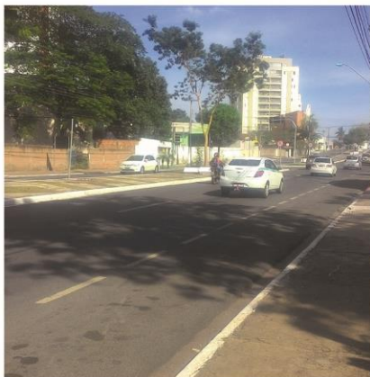
Av. Mato Grosso, com duas faixas viárias destinadas aos veículos em cada direção e uma ao estacionamento de automó-
