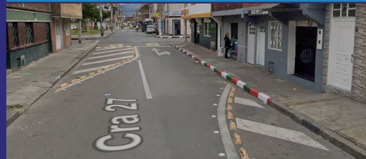
Figura 18 – Chicana implantada na via Carrera 27, no distrito de Tunjuelito, Bogotá.
