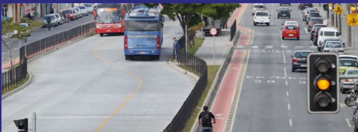
Figura 26 – Corredor de ônibus, com ciclovias e vias laterais com limite de 30 km/h em Curitiba.
