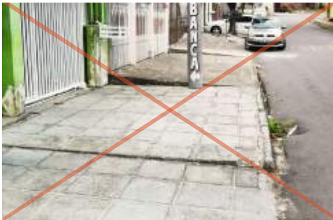
Rua no bairro Boqueirão | Ano: 2014 | Autoria: Ippuc DPR
