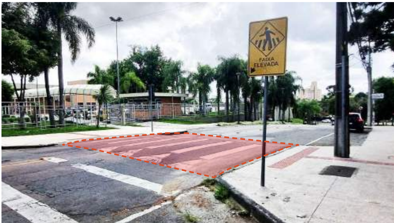
Travessia elevada na Rua João Parolin | Ano: 2024 | Autoria: Ippuc DPR
