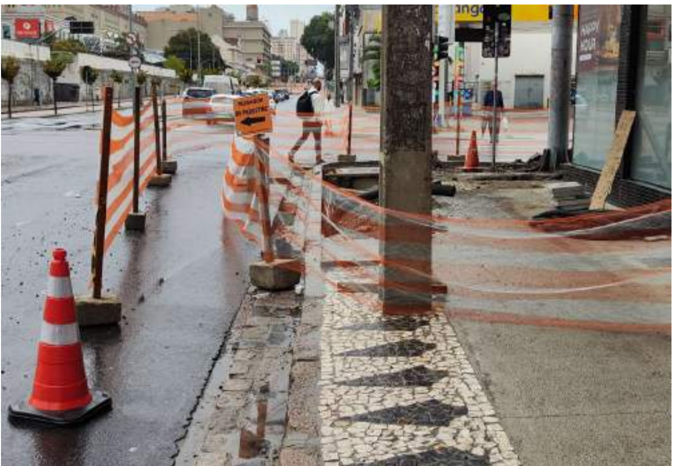
Sinalização temporária de obras | Autoria: Ippuc DPR
