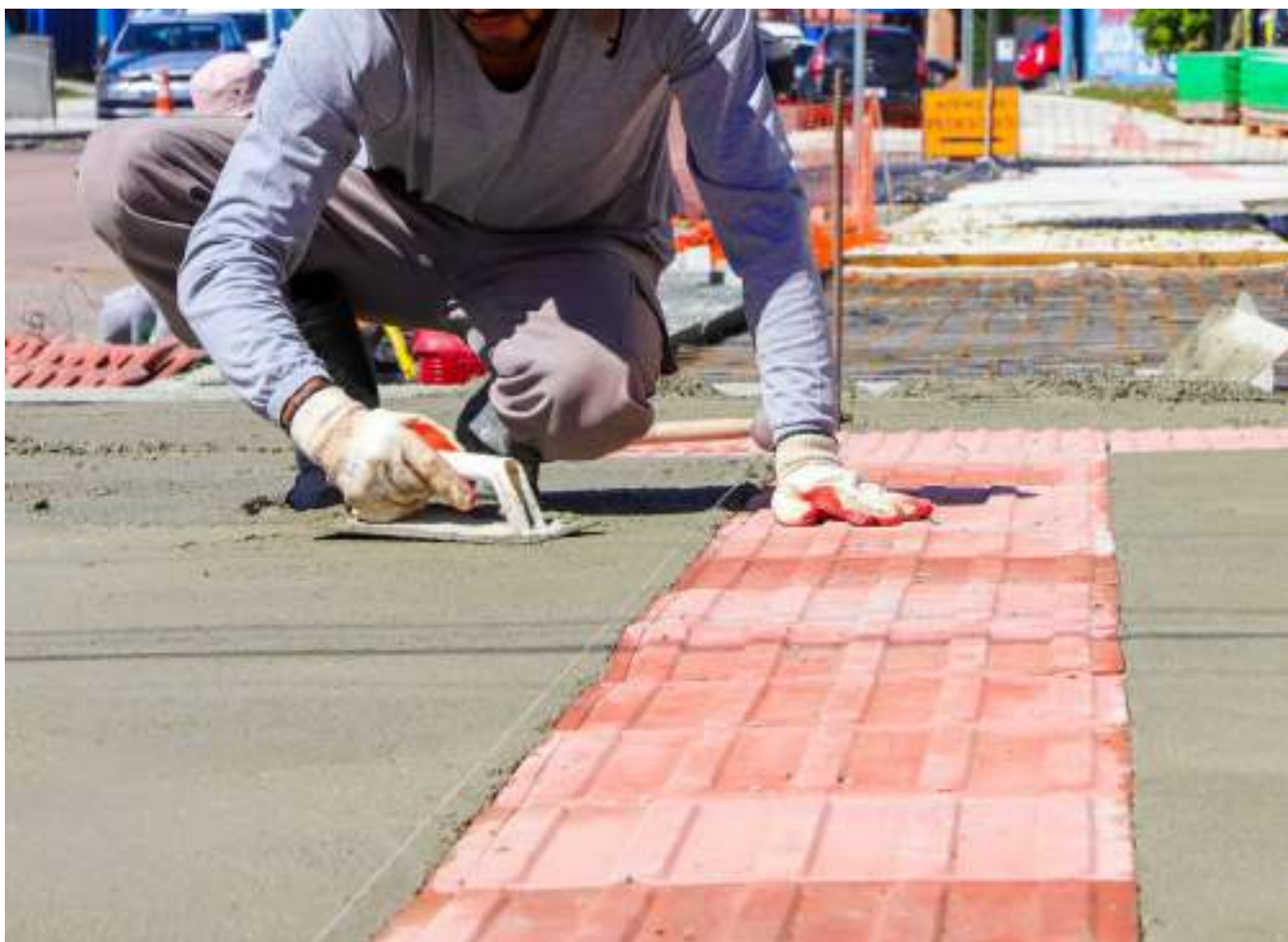
Piso tátil na Rua David Tows | Ano: 2024 | Autoria: Hully Paiva - SMCS
