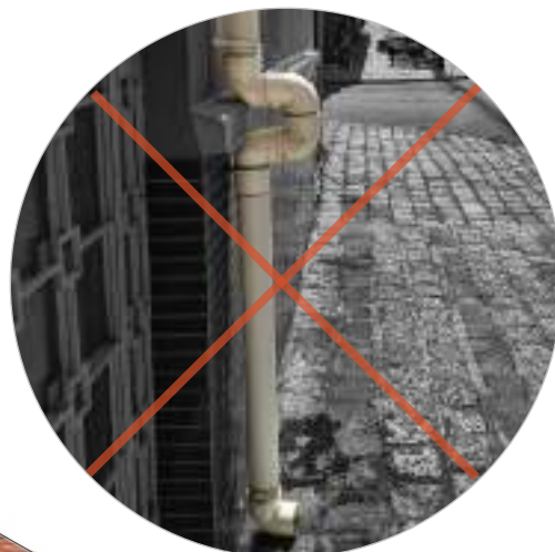
Situação inadequada: águas pluviais lançadas diretamente sobre a calçada Autoria: IPPUC DPR
