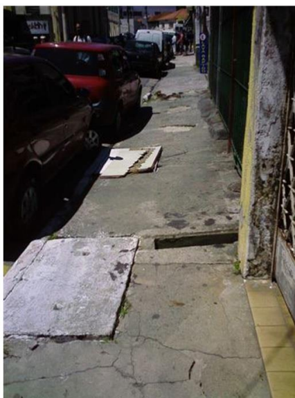
Figura 09: Mau estado da calçada localizada em São José Paulista, SP. Fonte: MOBILIZE BRASIL, 2013.
