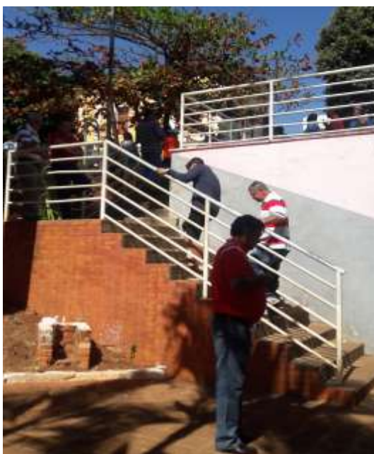
Foto 36 - Romaria (MG): escadaria de acesso aos banheiros públicos da Praça da Matriz (2016)
