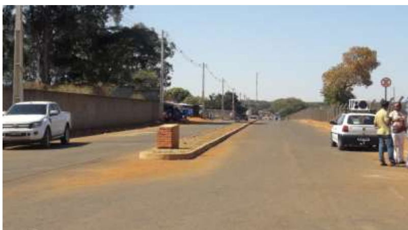
Foto 38 - Romaria (MG): avenida com canteiro central (2016)
