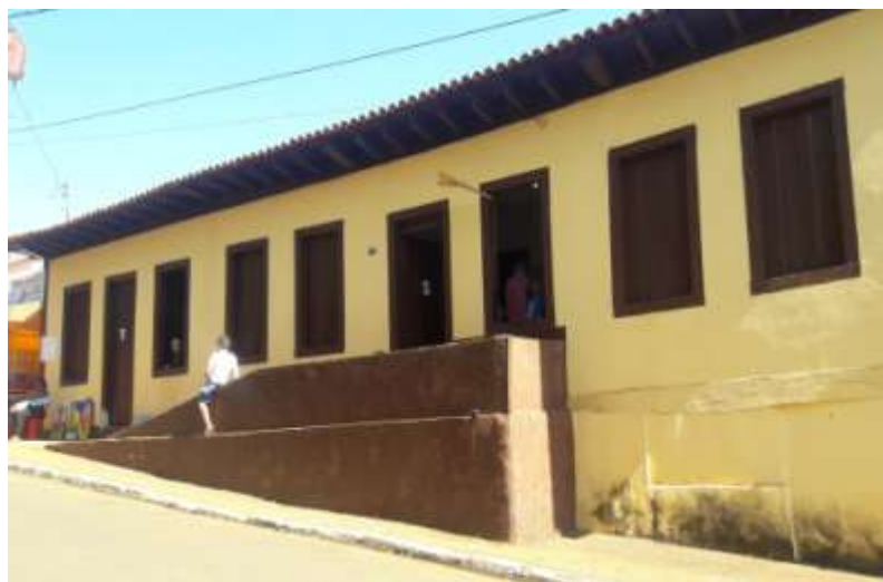
Foto 39 - Romaria (MG): residência com alicerce elevado (2016)
