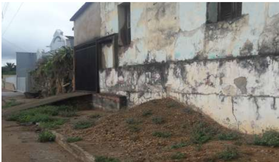
Fotos 1 e 2 - Estrela do Sul (MG): entulhos e obras de construção civil utilizando indevidamente as calçadas (2016)
