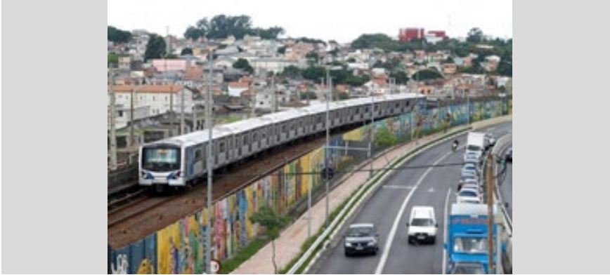
FIGURA 4 – Trilhos superficiais na Zona Leste de São Paulo.
