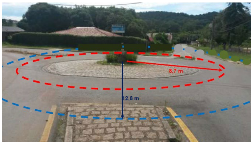
Figura 8 – Município de Almirante Tamandaré, traçado do raio de giro na rótula da rua Antônio Batista de Siqueira com a rua Bertolina Kendrich de Oliveira
