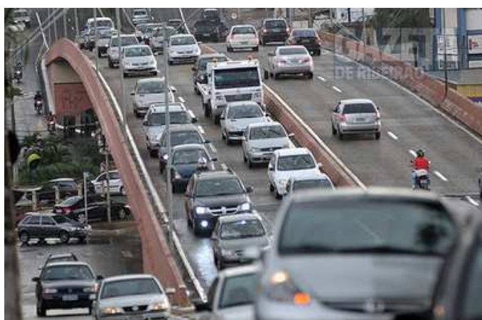
Figura 14 - Congestionamento no viaduto da Avenida Meira Junior com a Avenida Francisco Junqueira, em Ribeirão Preto 65
