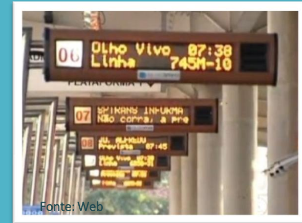
Painéis de LED (Estações)
