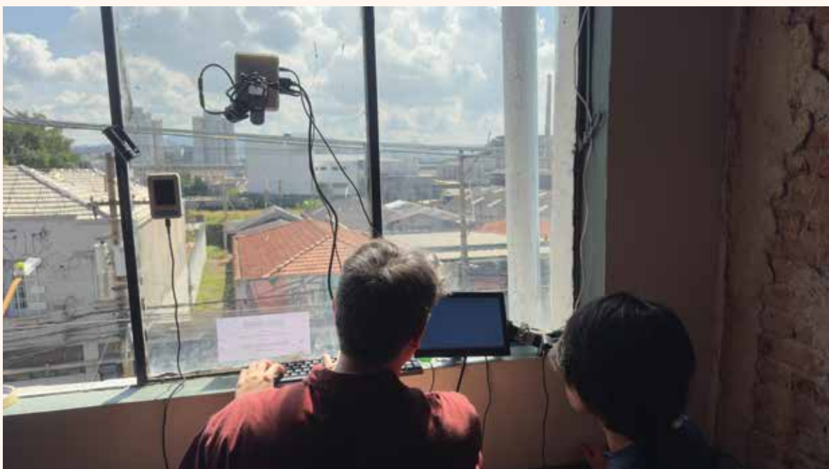
Figura 30 - Sensor Telraam S2 indoor sendo instalado em ZO1-014 (Rua Guaicurus, 815) em 13/04/2026 | Crédito: Yuri Vasquez (2026)
