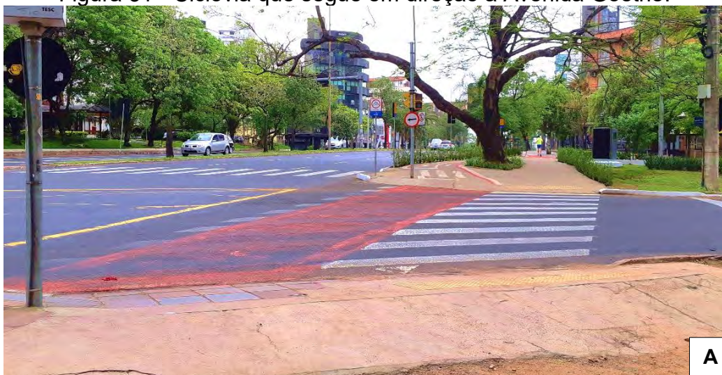
Figura 31 - Ciclovia que segue em direção à Avenida Goethe.
