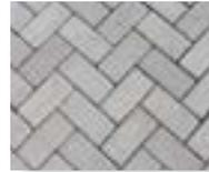
Pavimento de blocos de concreto pré-fabricados assentados sobre colchão de areia, travados através de contenção lateral e por atrito entre peças. Rejuntados com areia ou pó de pedra.
