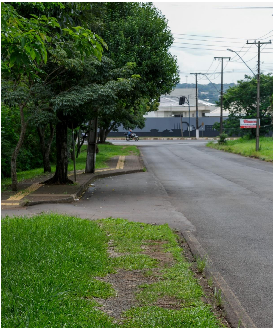
Figura 26: Falta de padronização das calçadas
