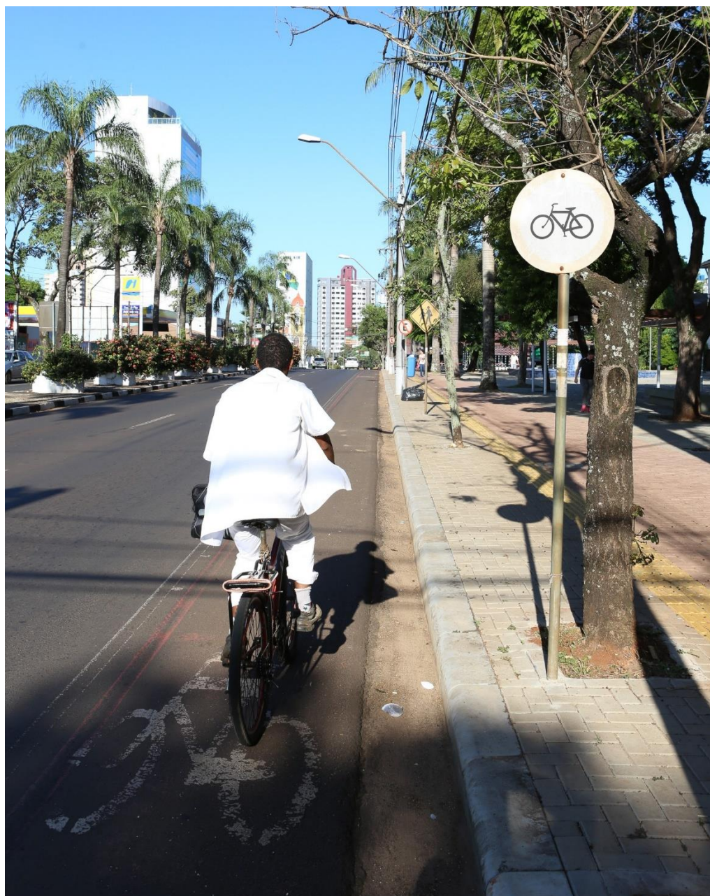
Figura 24: Ciclofaixa da Av. Jorge Schimmelpfeng com necessidade de manutenção
