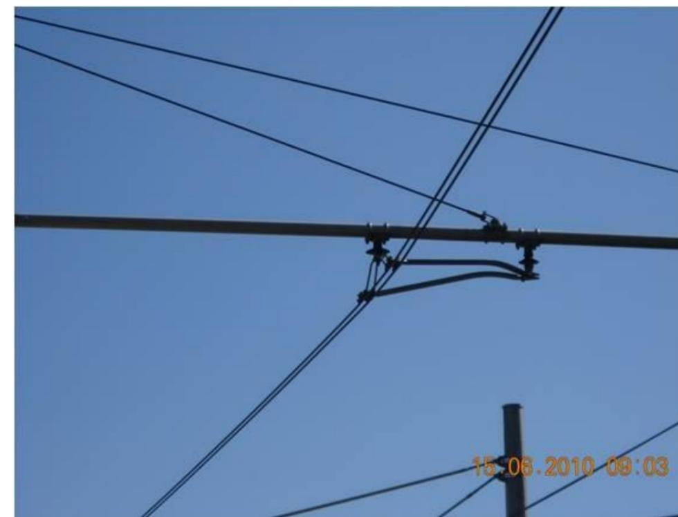
**Figura 3-57: Ilustração da suspensão da rede aérea**
