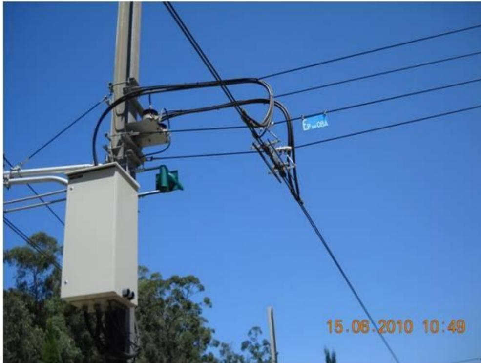
**Figura 3-59: Ilustração de para-raios em pontos de alimentação**
