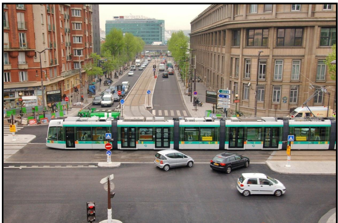
Foto 2.2.5 – VLT em operação na Avenue des Maréchaux – Linha T3 Paris (França)
