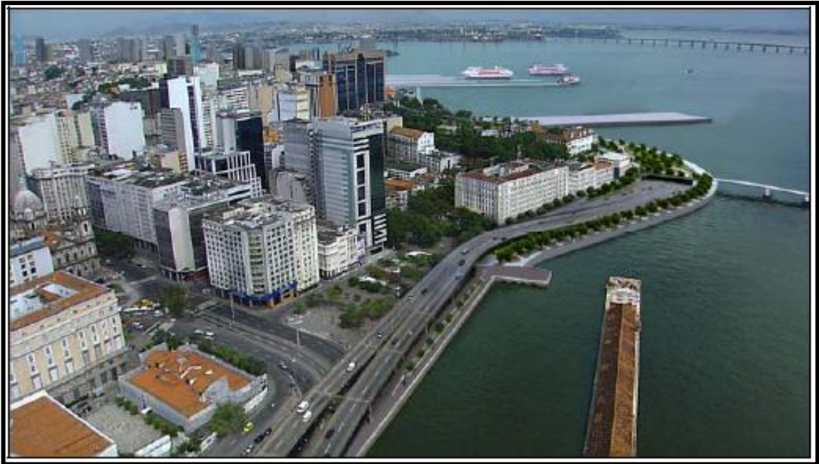
Figura 1.5.16 – Projeto Porto Maravilha – Arsenal da Marinha (Acesso ao Túnel)
