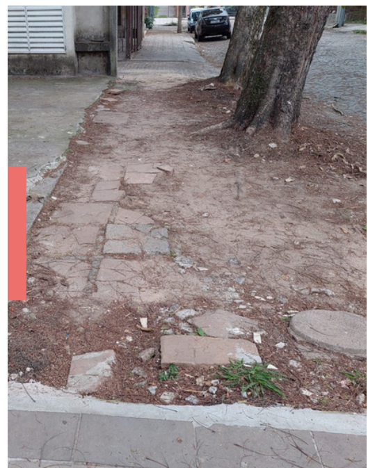
Calçada irregular Santa Maria-RS
