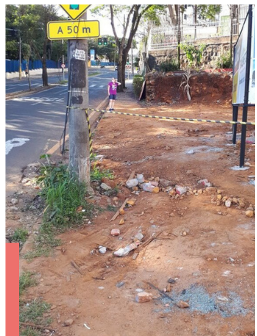
Calçada inexistente Piracicaba-SP
