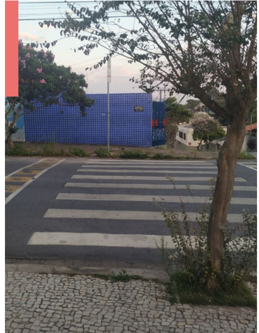
Rampa de acessibilidade inexistente Belo Horizonte-MG
