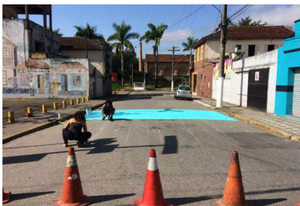
Figura G-13 | Demarcação do piso Zona 30 (Registro)
