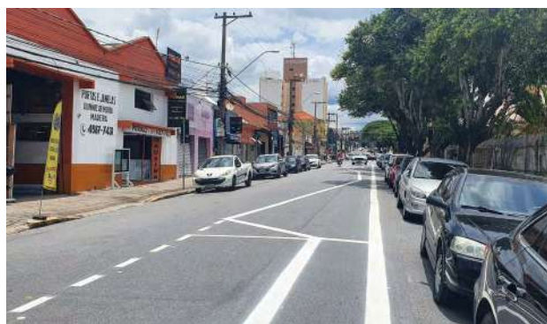
Figura F-9 | Início da implantação da sinalização horizontal - Rua Lacerda Franco (Jundiaí, 2/12/2022)
