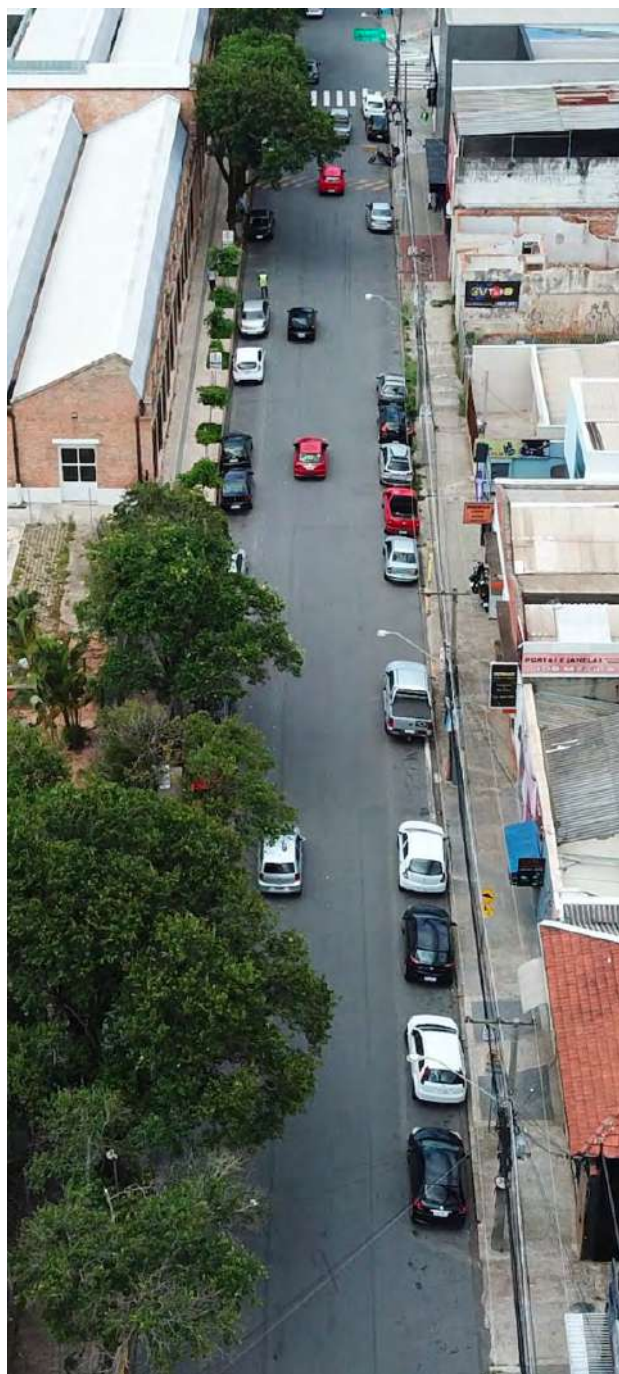
Figura F-6 | Área antes da intervenção
