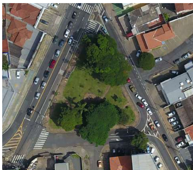
Figura E-16 | Rua Dr. Otávio Mendes antes da intervenção (Campinas)
