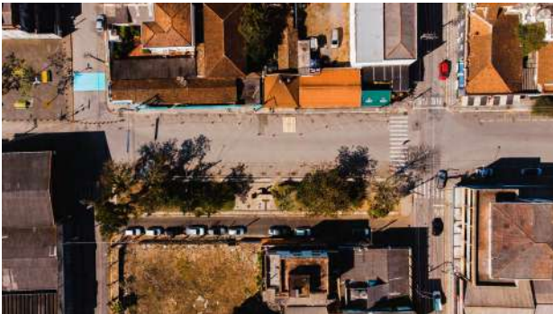
Figura G-6 | Boulevard Beira Rio, pré-intervenção (Registro)
