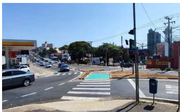
Figura E-21 | Cruzamento da Av. Andrade Neves x Rua Dr. Otávio Mendes após a intervenção (Campinas)
