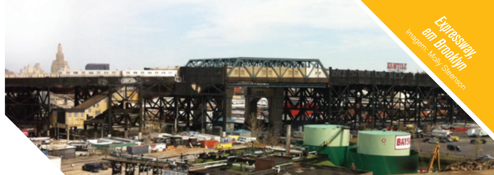
Mesmo em cidades ricas como Nova Iorque, os imóveis se desvalorizam próximo aos elevados, como nesta zona industrial do Brooklyn Queens.
